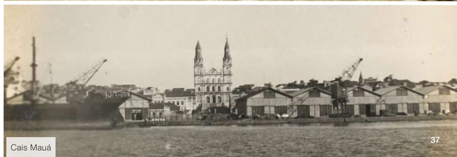
Construção das Docas do Cais
