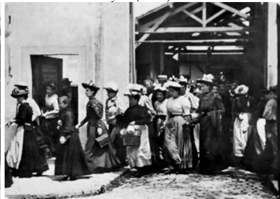
Figura 4 – A Saída da Fábrica Lumière em Lyon (1895)
