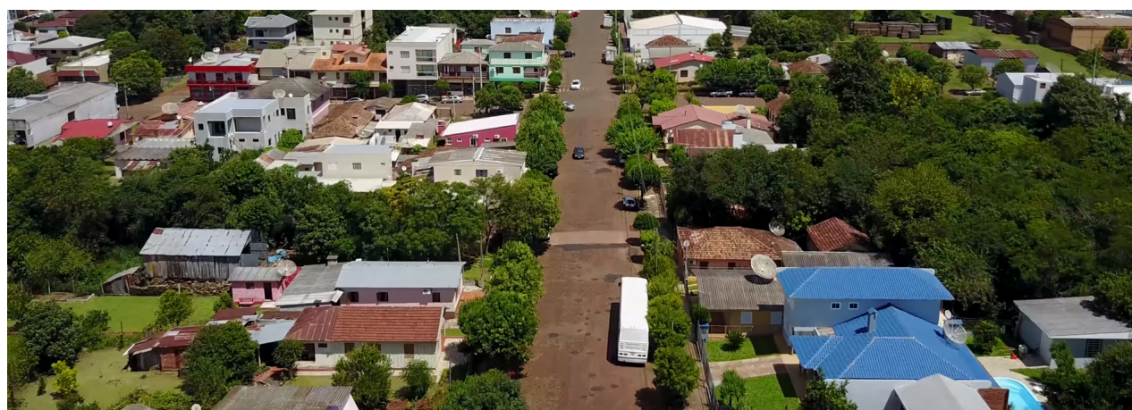
Vista aérea da ocupação residencial consolidada no entorno do Arroio Clarimundo, a ponte e a mata ciliar (dimensões inadequadas).
