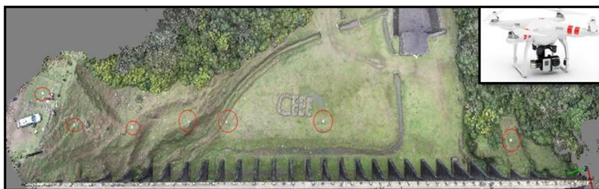
Figura 4– Pontos de Controle utilizados na Barragem de Canastra
