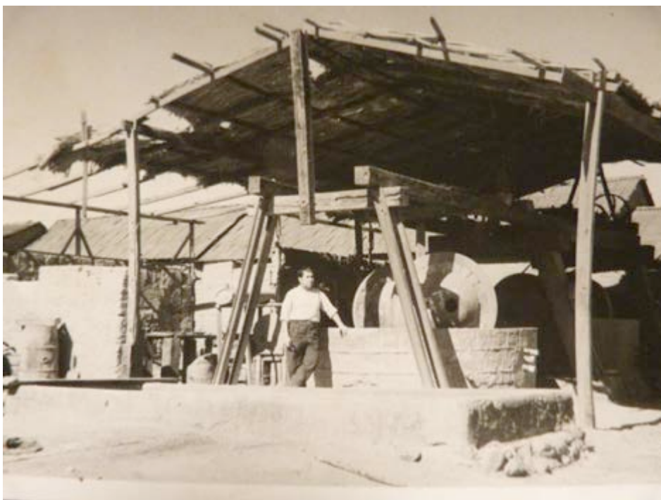
Fotografia 32: Trapiche , Usina de tratamento
