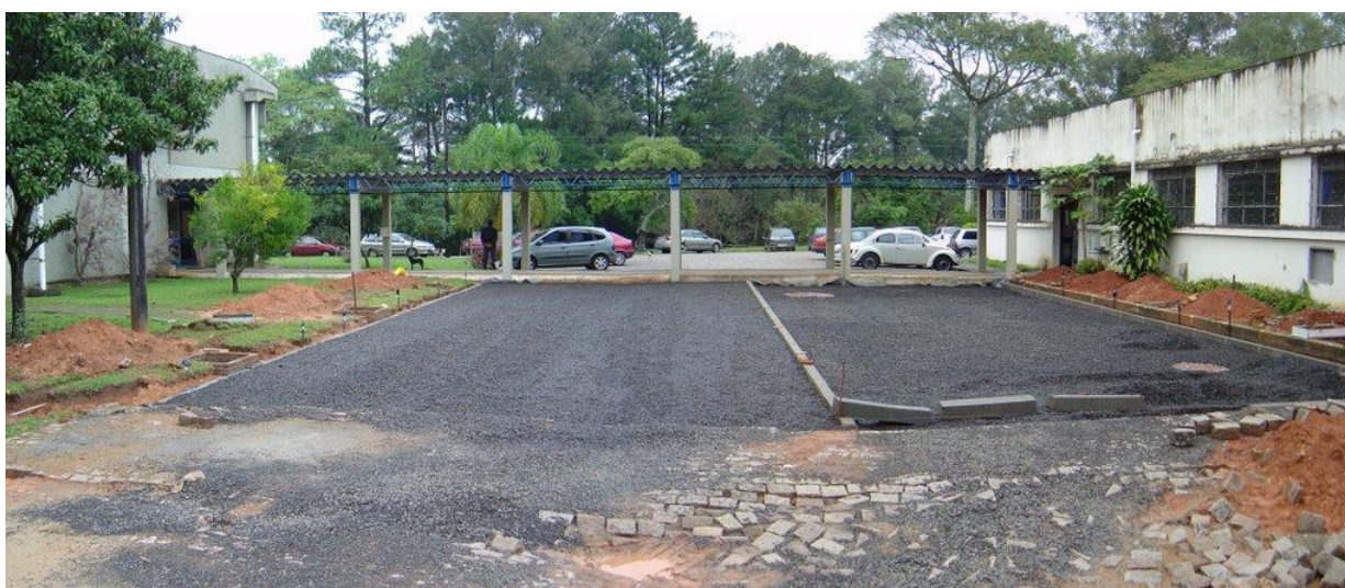
Figura 15 – Vista frontal do local do módulo experimental durante sua construção
