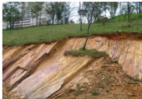
Figura 7 – Escorregamento planar em Nova Lima, MG
