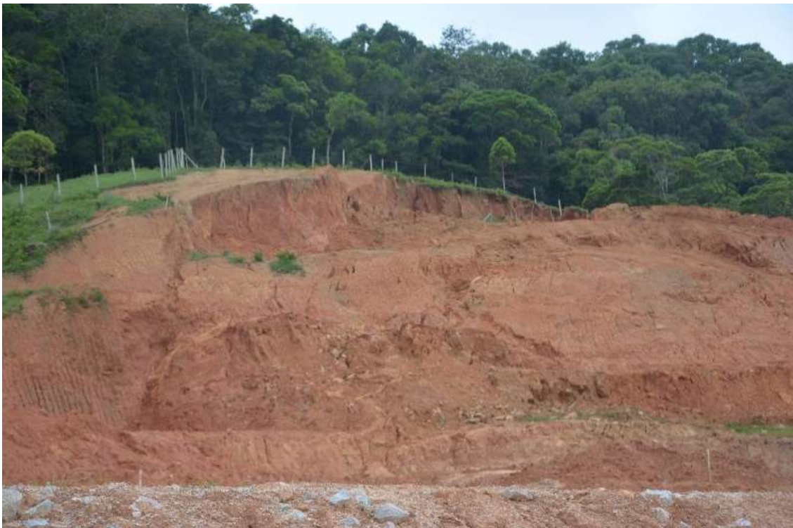
Figura 30 – Vista geral da encosta em novembro de 2015, em condição agravada
