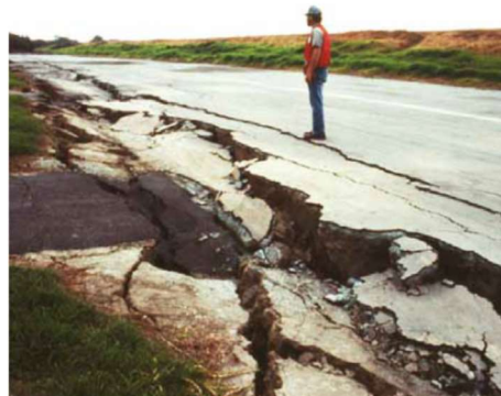
Figura 18 – Escoamento lateral como resultado de um terremoto na Califórnia, EUA
