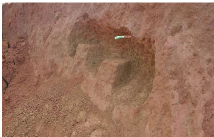
Figura 50 – Bancada de trabalho para moldagem dos blocos
