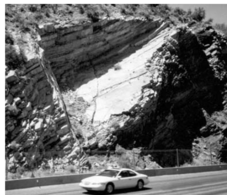
Figura 11 – Ruptura em cunha no Arizona, EUA
