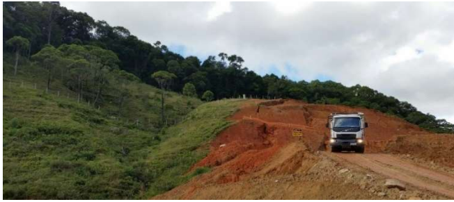
Figura 28 – Situação da encosta em julho de 2015
