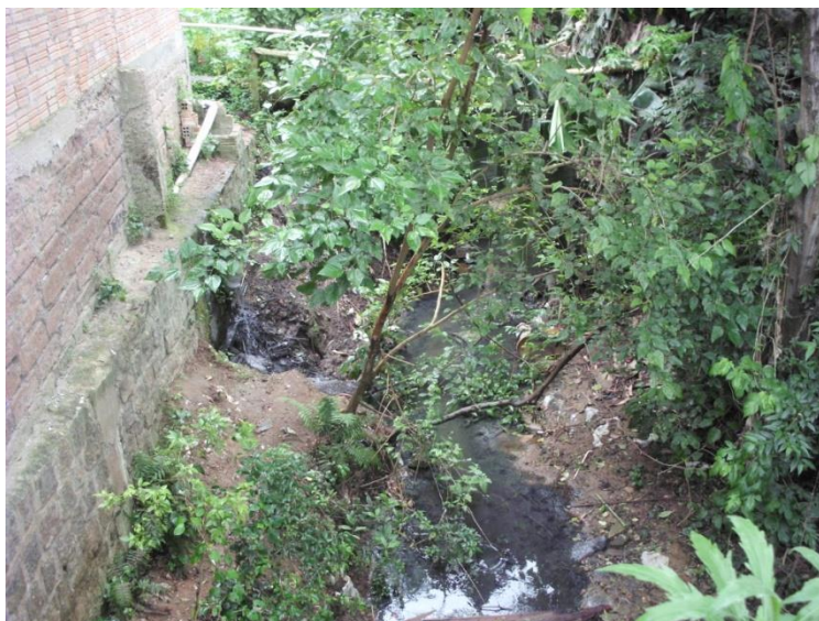
Figura 5-7. Ponte sobre córrego que recebe contribuições de tubulações de drenagem residencial.
