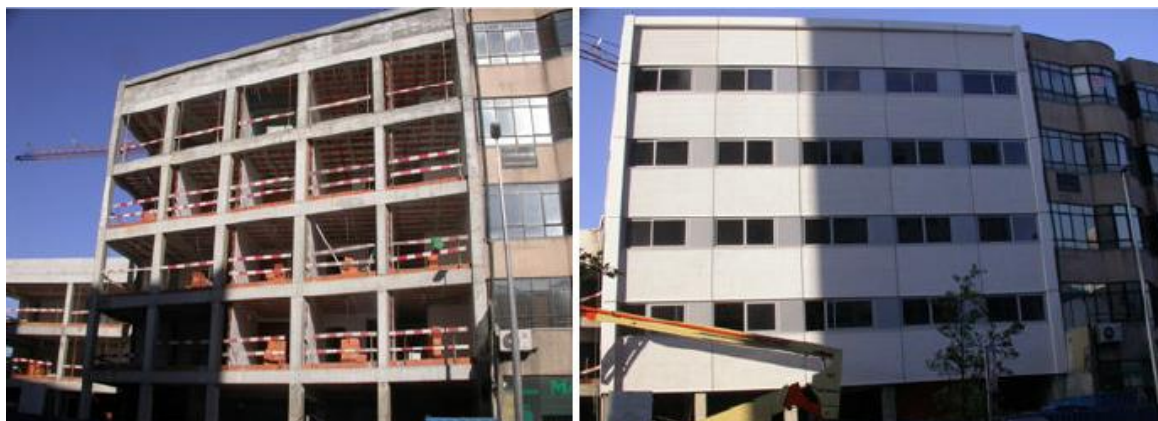
Figura 4 – Edifício com fachada em GRC, Portugal (a) antes das intervenções (b) após as intervenções
