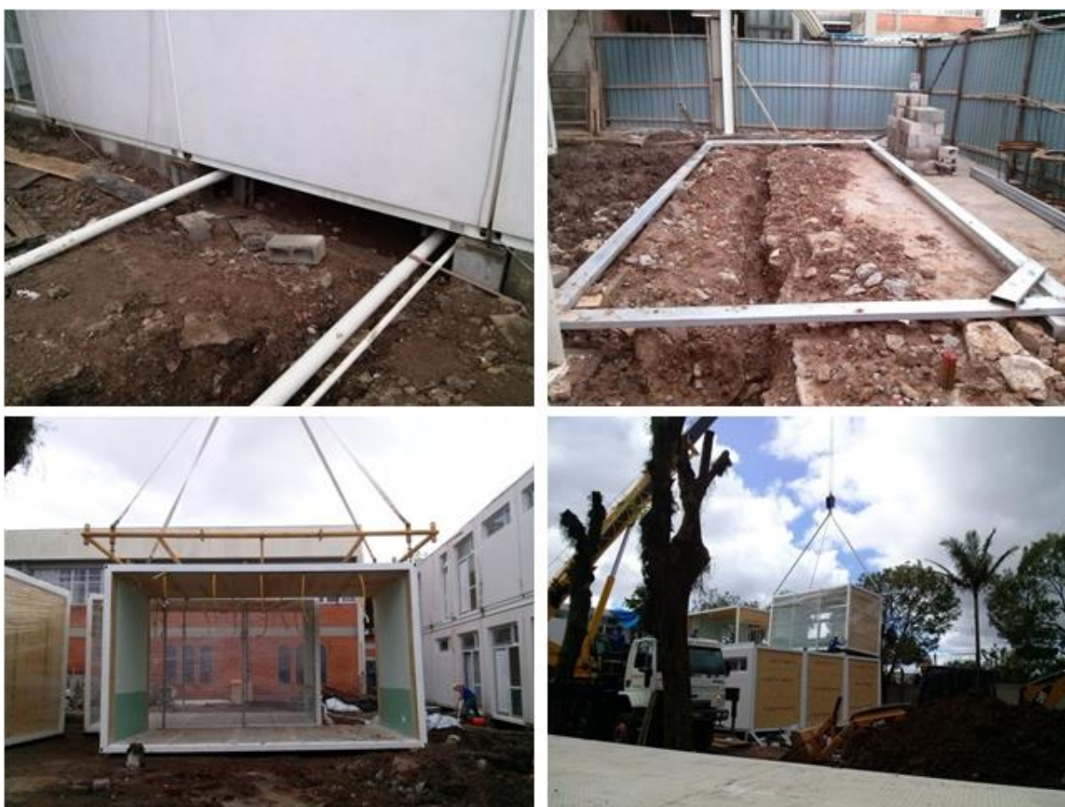
Figura 23 – a) tubulações hidráulicas b) aterramento c) início do içamento d) módulo sendo posicionado
