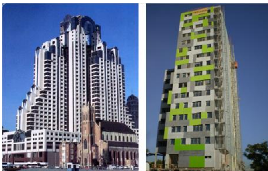
Figura 3 – (a) Hotel San Francisco Marriot, Estados Unidos e (b) edifício em Madrid, Espanha
