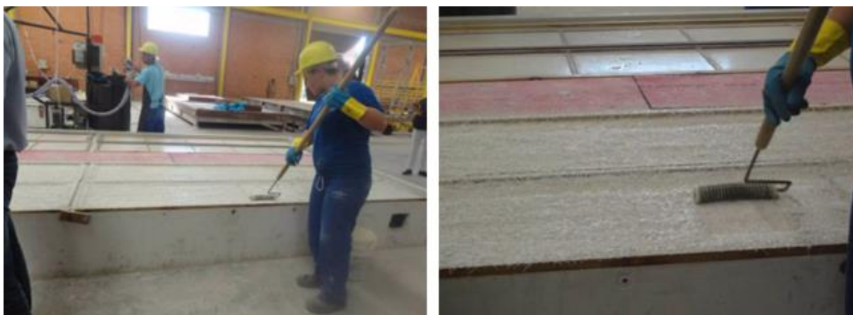
Figura 20 – compactação após processo de laminação
