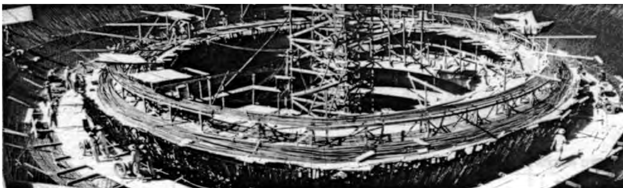
Fig. 4.438 - Oscar Niemeyer : Congresso Nacional, Brasília, 1956-60. montagem das formas na cúpula invertida da Câmara dos Deputados. [VASCONCELLOS, 1985]:97
