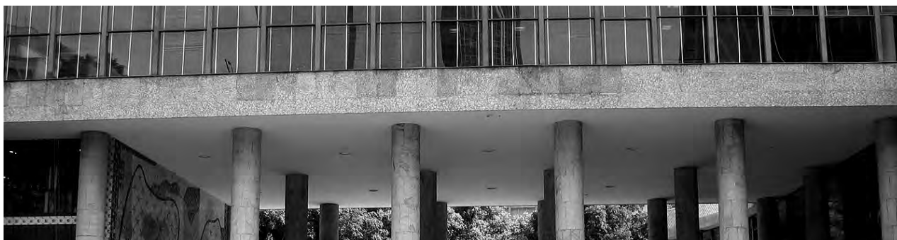
Fig. 4.57 - Lucio Costa e equipe: Ministério da Educação e Saúde Pública, 1936-45. Detalhe do lado sul, com o balanço maior da laje. Pode-se observar, abaixo das esquadrias, a faixa que corresponde internamente aos armários e a laje propriamente dita no topo dos pilares. [FOTO: MARCOS ALMEIDA, MARÇO 2004]
