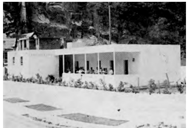
Fig. 4.61 - Oscar Niemeyer: Obra do Berço, Rio de Janeiro, 1937-42. Primeiro bloco, com apenas o térreo em maio de 1937. [PDF, maio de 1937]:140
