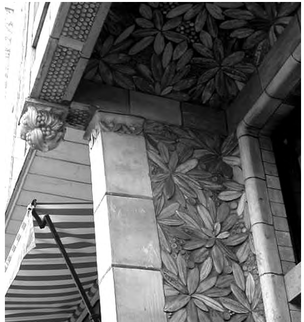
Fig. 1.43 - Auguste Perret: 25 bis da Rua Franklin, Paris, 1903-1905. Vista inferior do balanço da laje. [Disponível em < http://www.structurae.de/photos/paris25frank04.jpg > Acesso em 10 ago. 2003]
