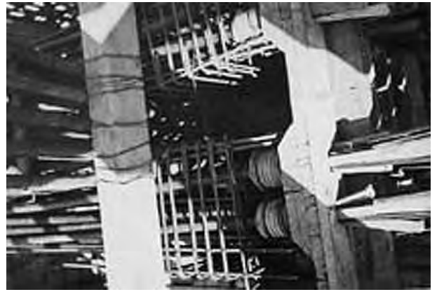
Fig. 4.372 - Affonso Eduardo Reidy: Museu de Arte Moderna, Rio de Janeiro, 1953-58/1967-68. Os cabos de pré-tensão das vigas superiores do corpo principal do museu. [CENTRO DE PESQUISA E DOCUMENTAÇÃO - MAM]
