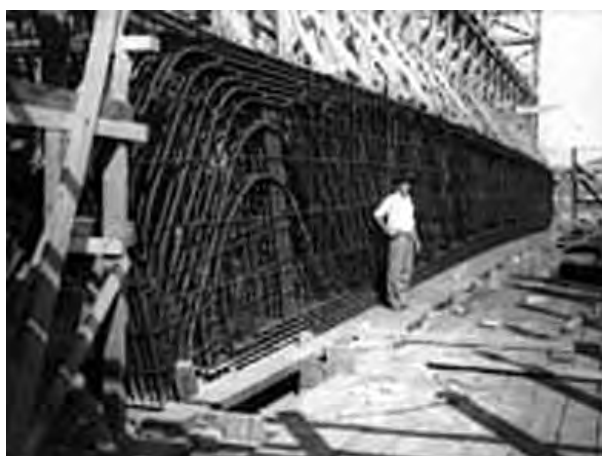
Fig. 4.386 - Armadura dos pórticos. [CENTRO DE PESQUISA E DOCUMENTAÇÃO - MAM]
