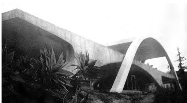
Fig. 4.242 - Oscar Niemeyer : Clube Diamantina, 1950. Clube em construção. [PAPADAKI, 1956]: 114
