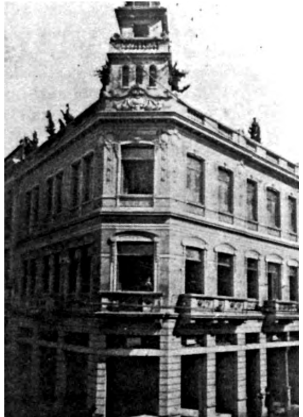
Fig. 1.77 - Francesco Notaroberto : O primeiro edifício em “cimento armado” em São Paulo, 1909. [VASCONCELOS,1985]:16
