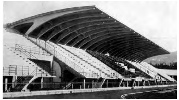
Fig. 2.05 - Pier Luigi Nervi: Estádio Municipal, Florença, 1929-32. Vista da marquise com 22m de balanço. [DESIDERI, 1982]:24
