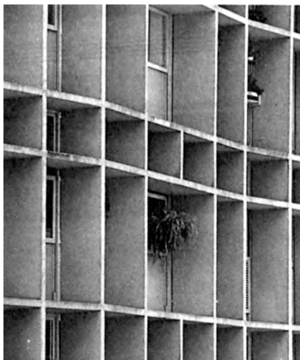
Fig. 4.348 - MMM Roberto: Edifício Finússia e Dona Fátima, Rio de Janeiro, 1952-54. Detalhe do sistema de proteção solar. [XAVIER,
