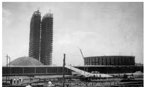
Fig. 4.435 - Oscar Niemeyer: Congresso Nacional, Brasília, 1956-60. Senado concluído e Câmara dos Deputados envolvida pelos andaimes. [PAPADAKI, 1960]:45
