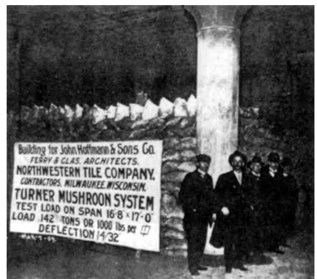
Fig. 1.51 - C.A.P Turner: teste de carregamento da J. Hoffmann Warehouse, Milwaukee, 1909. [GASPARINI, 2002]:1247
