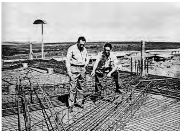
Fig. 4.413 - Oscar Niemeyer: Palácio da Alvorada, Brasília, 1957-58. Laje do 2º pavimento, fiscalizadas pelos engenheiros Marco Paulo Rabello e Darcy Amora Pinto. [VASCONCELLOS, 1985]:85
