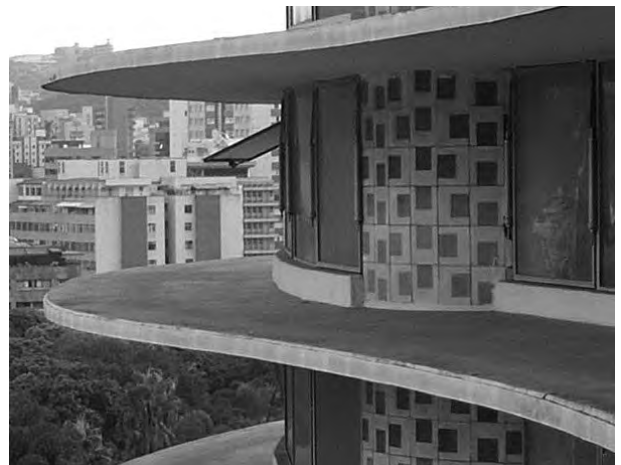
Fig. 4.400 - Oscar Niemeyer : Edifício Oscar Niemeyer, Belo Horizonte/MG, 1954-60. Detalhe das lâminas em balanço e a armação em relação aos pavimentos. [FOTO: MARCOS ALMEIDA, 2002]
