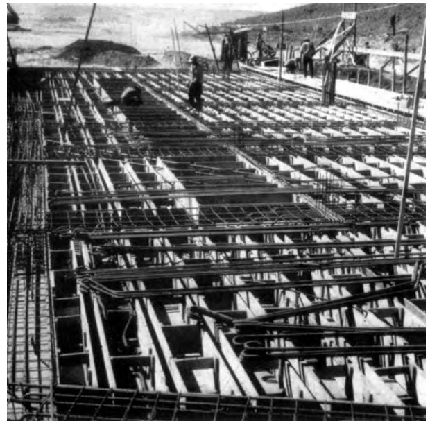
Fig. 4.450 - Oscar Niemeyer: Congresso Nacional, Brasília, 1956-60. Montagem das armaduras da grande laje. [AA nº80, 1956]
