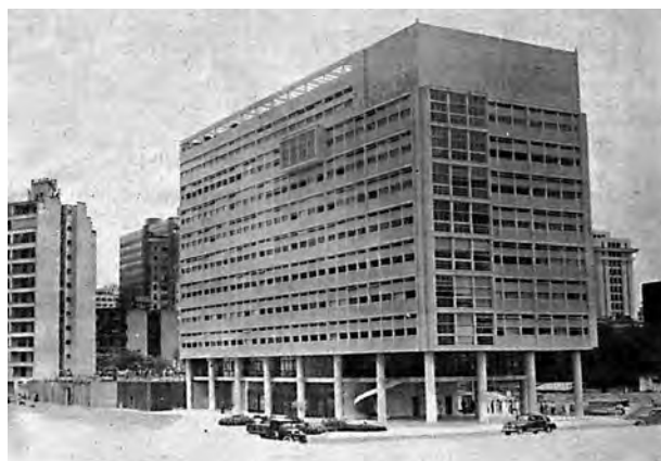
Fig. 4.134 - Marcello e Milton Roberto: Instituto de Resseguros do Brasil, Rio de Janeiro, 1941-42. A esbeltez dos pilotis chamou a atenção dos técnicos estrangeiros. [CONCRETO, nº74]:137
