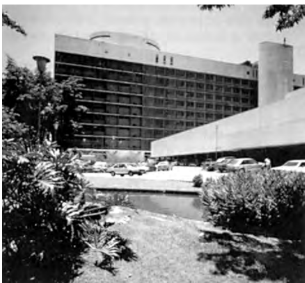
Fig. 4.358 - Oscar Niemeyer e Hélio Uchôa: Hospital Sul-América, Rio de Janeiro, 1952-59. Fachada posterior. [BOTEY, 1996]:116
