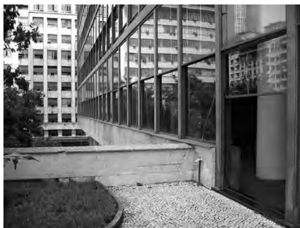
Fig. 4.56 - Lucio Costa e equipe : Ministério da Educação e Saúde Pública, 1936-45. Vista a partir do terraço do gabinete do ministro. Junção do peitoril do terraço com o peitoril interno, correspondendo aos armários embutidos. [FOTO: MARCOS ALMEIDA, MARÇO 2004]
