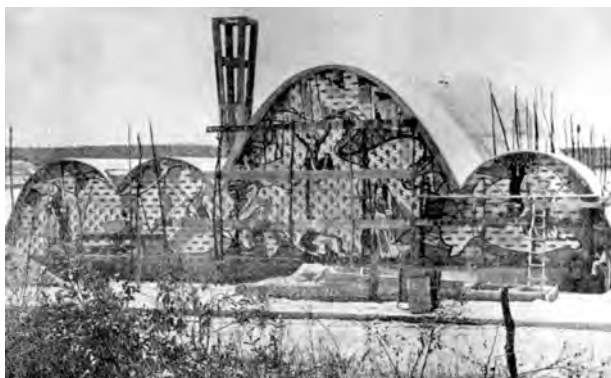
Fig. 4.157 - Oscar Niemeyer: Capela São Francisco de Assis, Belo Horizonte, 1944-45. A capela ainda com os andaimes. [COMAS, 2002]
