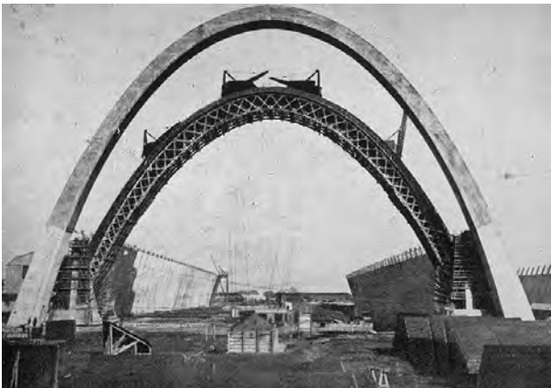
Fig. 1.74 - Eugène Freyssinet : Hangares em Orly, França, 1916-21. Montagem do cimbramento. [Disponível em < http://www.columbia.edu/cu/gsap/BT/BSI/VAULT/img0079.jpg > Acesso em 10 ago. 2003]
