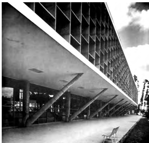
Fig. 4.262 - Oscar Niemeyer e equipe: Palácio das Nações e dos Estados (Parque do Ibirapuera), São Paulo, 1951-53. Pilotis. [PAPADAKI, 1956]: 139
