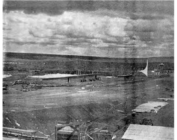
Fig. 4.429 - Oscar Niemeyer: Palácio do Planalto, Brasília, 1958-60. O terreno do palácio ainda nas fundações, com o modelo em escala natural dos pilares ao fundo. [BRASÍLIA, nº 24]: 04
