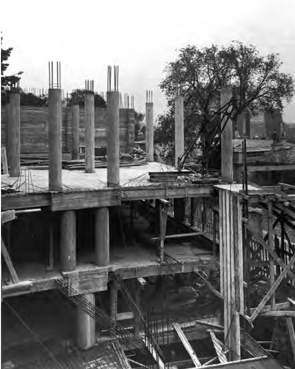
Fig. 3.67 - Auguste Perret : 51-55 da rua Raynouard , Paris, 1929-32. Edifício em construção, com destaque para as colunas em primeiro plano, que sustentam maiores vãos à medida que sobem em altura, diminuindo sua seção na razão inversa. [GARGIANI, 1994]:100
