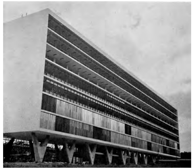
Fig. 4.303 - Oscar Niemeyer: Palácio da Agricultura (Parque do Ibirapuera), São Paulo, 1955. Edifício em construção. [MINDLIN, 2000]:212
