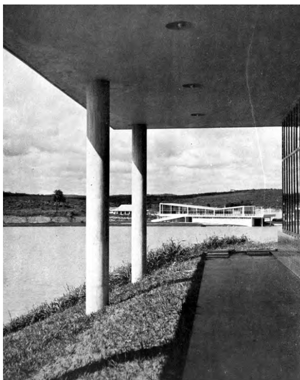
Fig. 4.114- Oscar Niemeyer : Cassino da Pampulha, Belo Horizonte, 1940-42. Vista dos pilares externos onde pode-se perceber o balanço de laje (ao fundo o Iate Clube). [COMAS, 2002]
