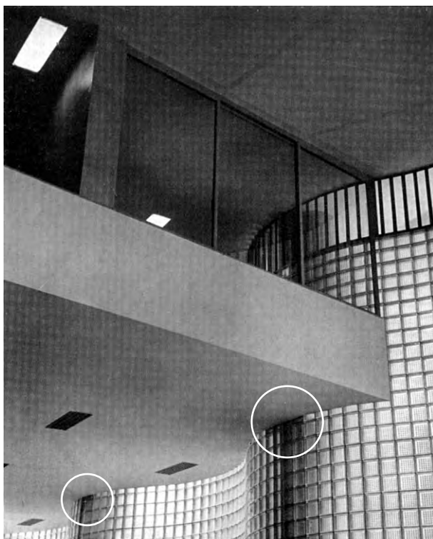
Fig. 4.184 - Oscar Niemeyer : Banco Boa Vista, Rio de Janeiro, 1946. Detalhe do recorte da laje do mezanino e a indicação dos consolos que conectam os pilares externos. [PAPADAKI, 1956]: 36
