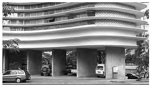
Fig. 4.391 - Oscar Niemeyer: Edifício Oscar Niemeyer, Belo Horizonte/MG, 1954-60. Detalhe do térreo e pilotis. [FOTO: MARCOS ALMEIDA, 2002]
