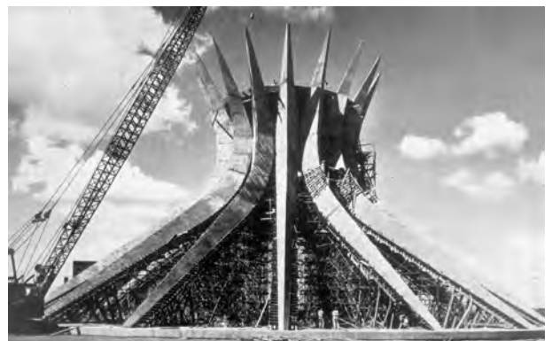
Fig. 4.459 - Oscar Niemeyer: Catedral de Brasília (nave principal), 1959-60. Retirada das formas e escoras. [Módulo nº18]:24
