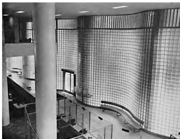
Fig. 4.186 - Oscar Niemeyer: Banco Boa Vista, Rio de Janeiro, 1946. O espaço interno do térreo a partir do mezanino e a parede sinuosa construída em tijolo de vidro. [PAPADAKI, 1951]: 151
