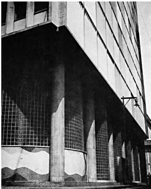
Fig. 4.190 - Oscar Niemeyer: Banco Boa Vista, Rio de Janeiro, 1946. Detalhe dos pilares em relação à parede sinuosa. [PAPADAKI, 1951]: 147
