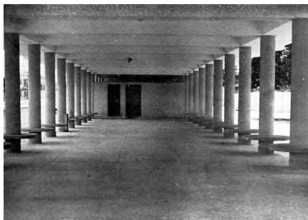
Fig. 4.140 - Álvaro Vital Brazil: Escola Raul Vidal, Niterói, 1941. Vista da parte inferior da laje do primeiro teto, com as vigas aparentes. [PDF, Abr. 1944]:60
