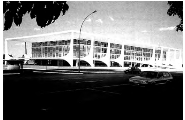
Fig. 4.421 - Oscar Niemeyer: Palácio do Planalto, Brasília, 1958-60. Nesta imagem, a perspectiva do palácio com o avanço da laje de cobertura. [BOTTEY, 1986]:128
