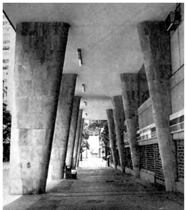
Fig. 4.343 - MMM Roberto: Edifício Marquês de Herval, Rio de Janeiro, 1952-1955. Os pilares de seção variável da avenida Almirante Barroso [XAVIER, 1996]:81
