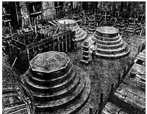
Fig. 2.47 - Fundações circulares em concreto (sem armadura) resistentes ao carregamento de 1.600 toneladas, podendo suportar pilares de até 24 andares. [Engineering News Record, abril, 1945]:74
