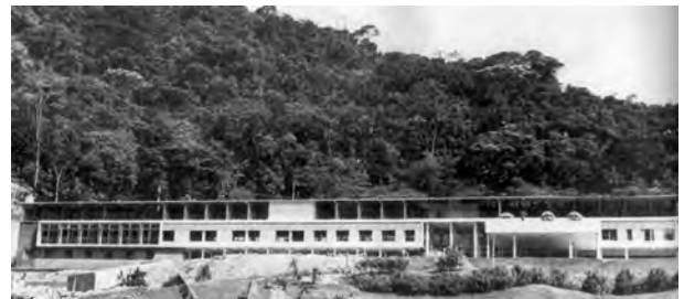
Fig. 4.172 - MM Roberto : Colônia de Férias do IRB, Rio de Janeiro, 1944. Edifício em construção. [MINDLIN, 2000]: 130
