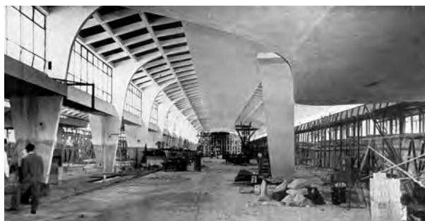
Fig. 4.261 - Oscar Niemeyer : Fábrica Duchen, São Paulo/SP, 1950-51. Vista interna do bloco industrial, com a escada de acesso ao mezanino em primeiro plano. [REVISTA POLITÉCNICA, nº 164]
