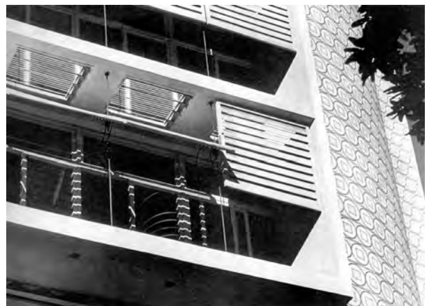
Fig. 4.232 - MMM Roberto: Edifício Seguradoras, Rio de Janeiro, 1949-50. Detalhe da proteção solar. [MINDLIN, 2000]:236
