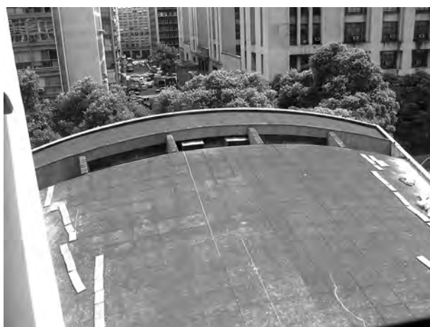
Fig. 4.51 - Lucio Costa e equipe: Ministério da Educação e Saúde Pública, 1936-45. Vista da cobertura do auditório. [FOTO: MARCOS ALMEIDA, MARÇO 2004]
