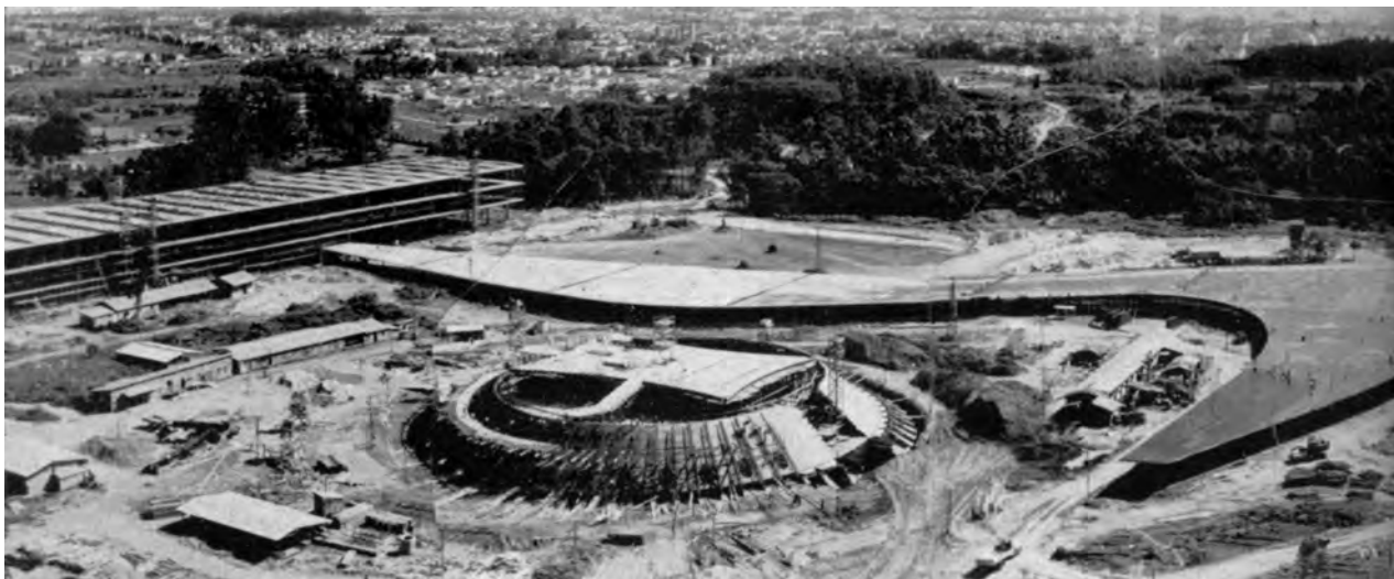
Fig. 4.317 - Oscar Niemeyer e equipe: Grande Marquise do Ibirapuera, São Paulo, 1951-55. Vista aérea no período de execução da grande laje, com o Palácio das Artes (OCA) em primeiro plano. [ACRÓPOLE nº185]: 216
