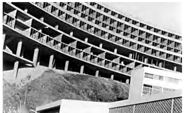
Fig. 4.217 - Affonso Eduardo Reidy: Conjunto Pedregulho, Bloco "A", Rio de Janeiro, 1948-58. Bloco "A" em construção. [REIDY, 1999]:88
