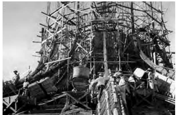
Fig. 4.458 - Oscar Niemeyer: Catedral de Brasília (nave principal), 1959-60. Detalhe da montagem ds formas. [Disponível em < http://www.memorialjk.com.br/4/fotos/pgs/brasilia/fts/ft14.jpg > Acesso em 20 ago. 2003]
