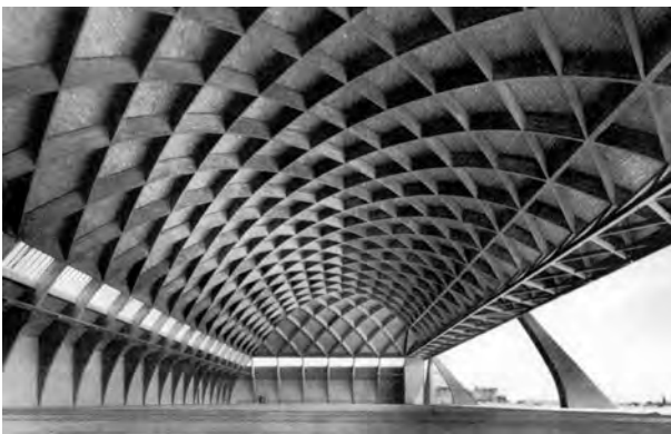
Fig. 2.11 - Pier Luigi Nervi : hangar em Orvieto, 1935. Vista interna da grelha rotacionada em relação ao eixo longitudinal. [DESIDERI, 1982]:28
