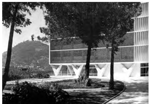
Fig. 4.356 - Oscar Niemeyer e Hélio Uchôa: Hospital Sul-América, Rio de Janeiro, 1952-59. Vista dos pilotis no nível do acesso principal. [BOTEY, 1996]:114
