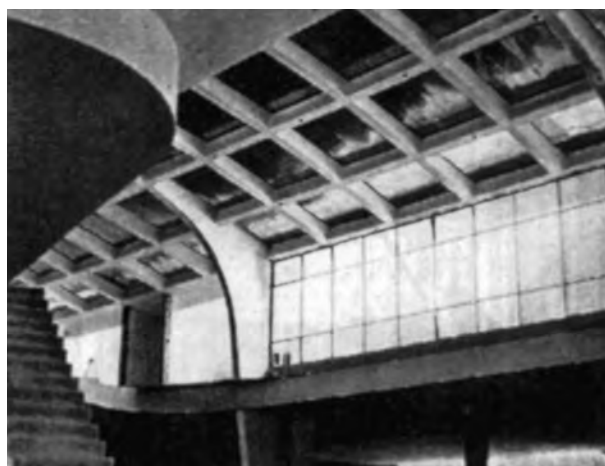
Fig. 4.250 - Oscar Niemeyer: Fábrica Duchen, São Paulo/SP, 1950-51. Vista interna do Pavilhão Industrial em obras e a grelha em concreto da cobertura. [COLLARES, 2003]: 84
