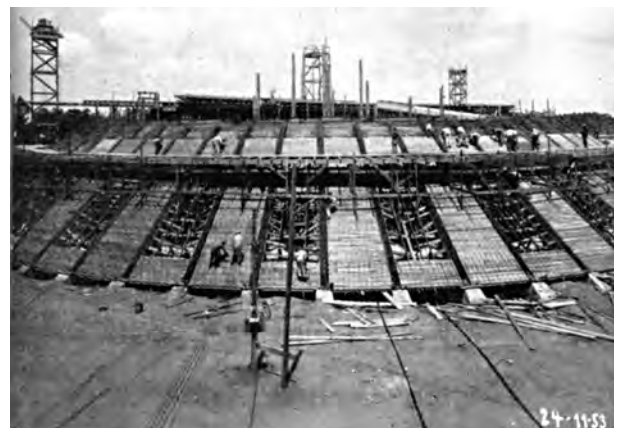
Fig. 4.294 - Oscar Niemeyer: Palácio das Artes (Parque do Ibirapuera), São Paulo, 1953-54. Preparação das armaduras e das guias do cimbrequil em 24 de novembro de 1953. [ACRÓPOLE n°191]:495
