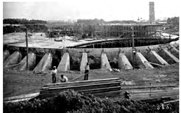
Fig. 4.293 - Oscar Niemeyer: Palácio das Artes (Parque do Ibirapuera), São Paulo, 1953-54. Detalhes do anel circular em concreto armado, das fundações e da laje do térreo em 3 de agosto de 1953. [ACRÓPOLE n°191]:496
