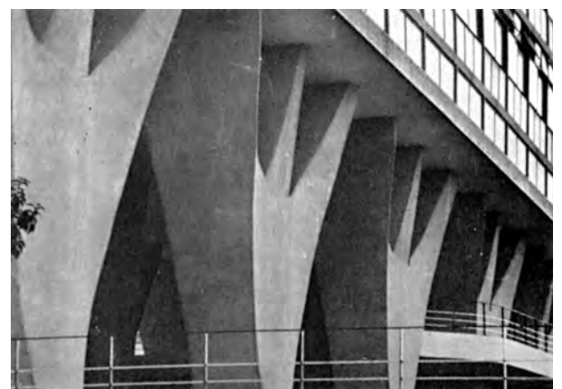
Fig. 4.321 - Oscar Niemeyer : Edifício Governador Kubitschek, Belo Horizonte, 1951. Pilotis com pilares em “W”. [BRUAND, 1981]:151
