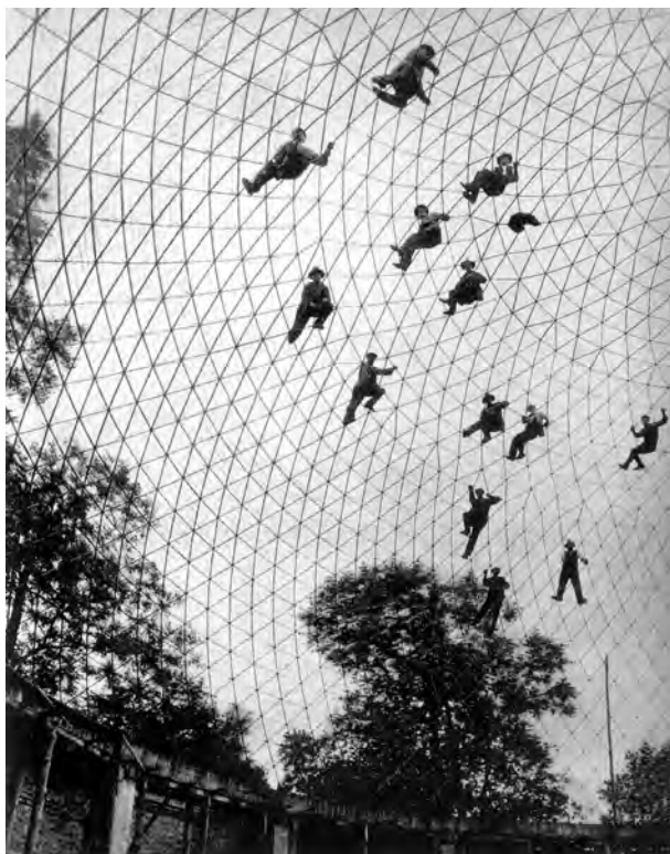
Fig. C.26 - Walter Bauersfeld, Dyckerhoff & Widmann : Planetário em Jena, Alemanha, 1924-25. Malha da cúpula durante a construção: vão de 25 metros com casca em concreto armado de apenas 6 centímetros de espessura. [GÖSSEL, 2001]: 104
