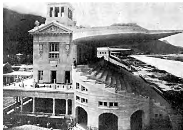
Fig. 2.39 - Archimedes Memória e Francisque Cuchet (arquitetos), Christiani e Nielsen (construtora): Tribuna dos Sócios do Jockey Club do Rio de Janeiro, 1924. A marquise com seus 22,40m de balanço foi uma das obras que se destacaram internacionalmente pelo arrojo estrutural. [CONCRETO, nº15 dez de 1938]:202
