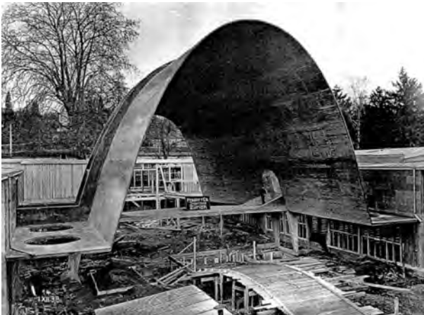
Fig. 2.19 - Robert Maillart : Cement Hall, Zúrique. Vista do arco parabolóide sem as formas em 1º de dezembro de 1938. [BELLINGTON, 1990]:235a
