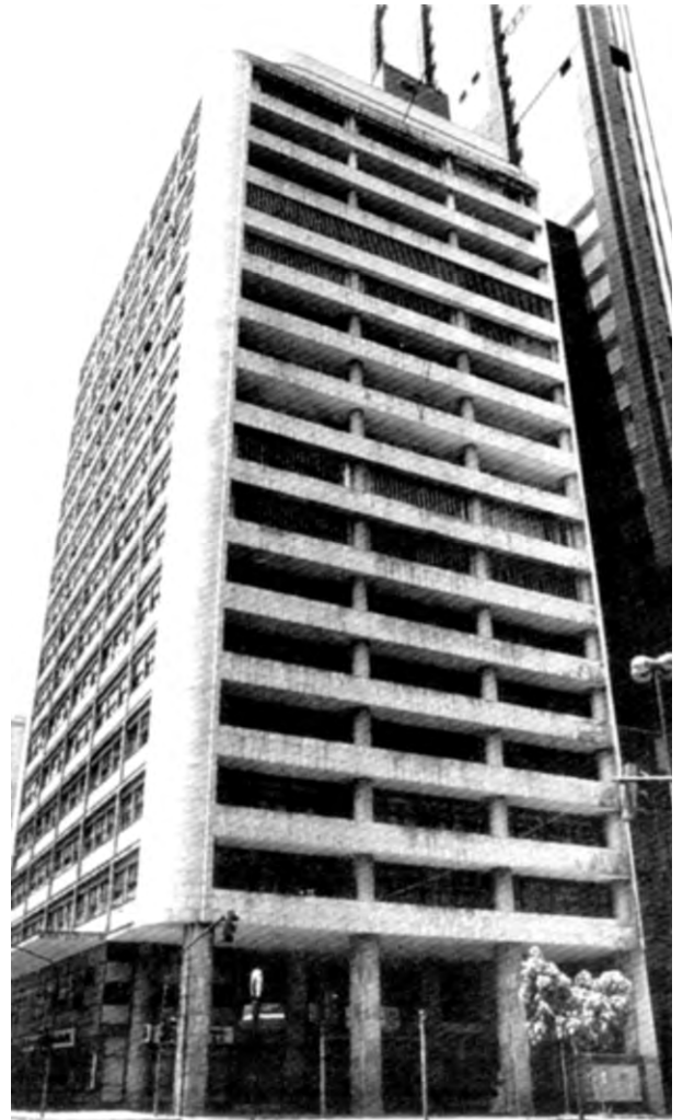
Fig. 4.84 - Marcelo e Milton Roberto: Edifício Valparaíso, Rio de Janeiro, 1937-44. Fachada. [XAVIER, 1991]:45
