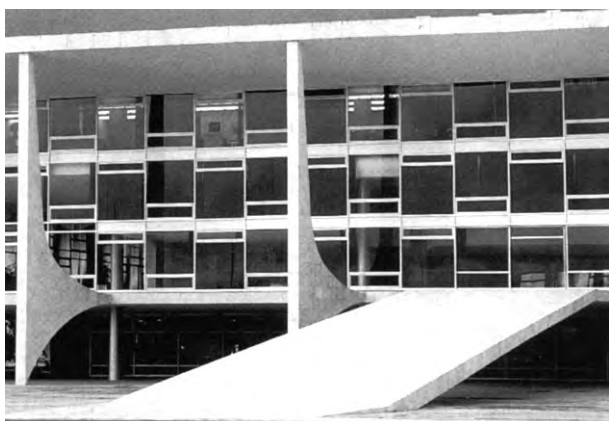
Fig. 4.425 - Oscar Niemeyer: Palácio do Planalto, Brasília, 1958-60. A laje de cobertura possui o mesmo aspecto na fechada que as lajes dos pavimentos superiores, mesmo com a supressão de dois apoios. [BOTEY, 1996]: 128
