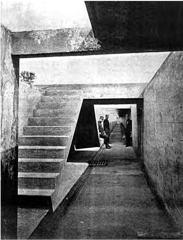
Fig. 1.31 - Société Anonyme de Travaux et ciments et béton armé : Corpo de tropa montada de Comboire (Isère, França), 1901. Sistema Hennebique. [RASSEGNA n° 49]:13
