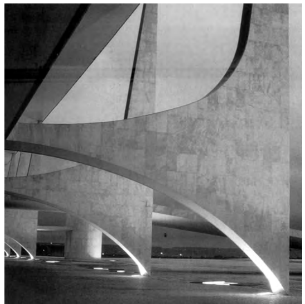
Fig. 4.423 - Oscar Niemeyer: Palácio do Planalto, Brasília, 1958-60. Detalhe do encontro dos pilares com o solo. [BOTTEY, 1996]:129
