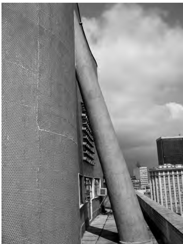
Fig. 4.59 - Lucio Costa e equipe: Ministério da Educação e Saúde Pública, 1936-45. Detalhe do pilar oblíquo que contraventa o volume superior. [FOTO: MARCOS ALMEIDA, MARÇO 2004]
