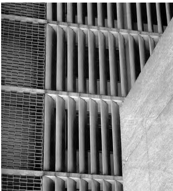
Fig. 4.359 - Oscar Niemeyer e Hélio Uchôa: Hospital Sul-América, Rio de Janeiro, 1952-59. Detalhe da proteção solar. [BOTEY, 1996]:117
