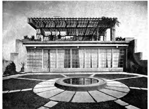
Fig. 2.34 - Emílio Baumgart : ampliação do edifício "A Noite". Vista da pérgola após a conclusão dos trabalhos de reforço estrutural. As cortinas das janelas ocultam o auditório da Rádio Nacional. [CONCRETO n°75 jun de 1945]:183
