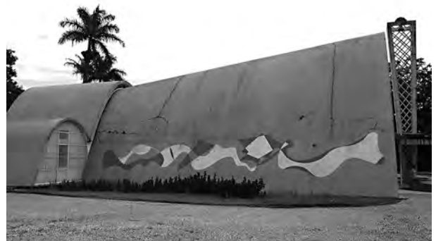
Fig. 4.155 - Oscar Niemeyer: Capela São Francisco de Assis, Belo Horizonte, 1944-45. Vista lateral. [COMAS, 2002]
