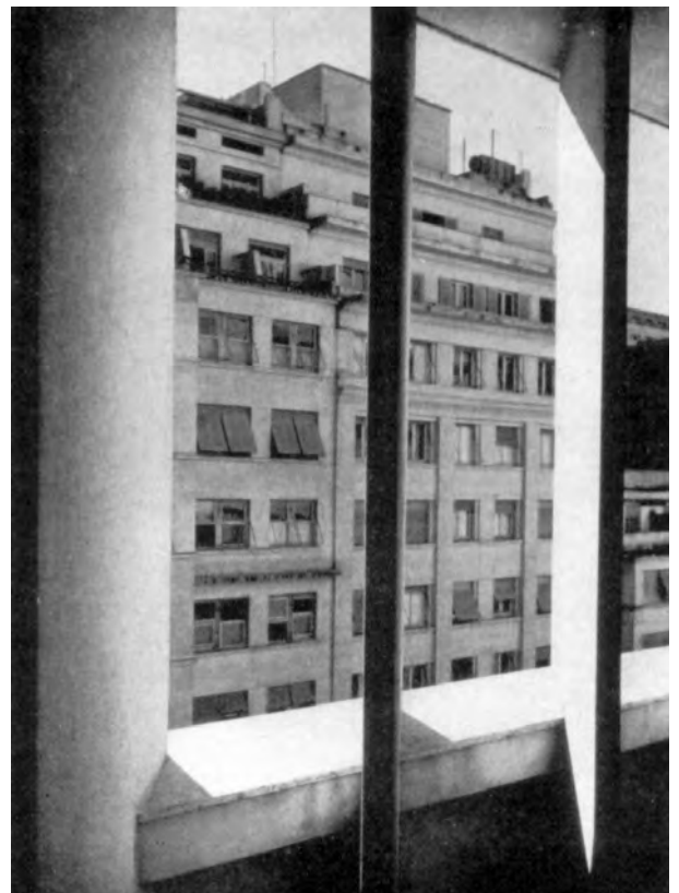
Fig. 4.28 - Marcelo e Milton Roberto: Associação Brasileira de Imprensa, 1936-38. Os brises fixos em concreto, engastados na vigota superior do balcão em balanço.
