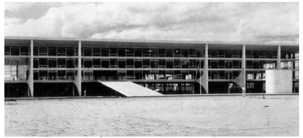
Fig. 4.428 - Oscar Niemeyer: Palácio do Planalto, Brasília, 1958-60. Fachada principal, com a supressão dos pilares no vão da rampa. [AA nº90, 1960]
