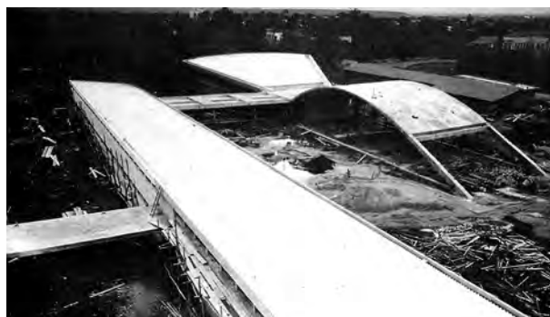
Fig. 4.362 - Oscar Niemeyer: Escola Estadual, Campo Grande/MS, 1952. Vista superior da escola em construção. [PAPADAKI, 1956]: 178
