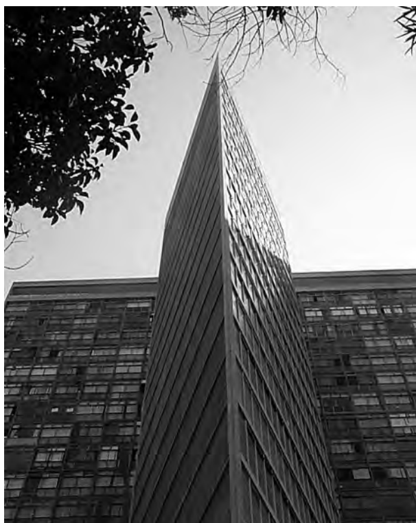
Fig. 4.329 - Oscar Niemeyer : Edifício Governador Kubitschek, Belo Horizonte, 1951. Vista frontal do núcleo de circulação com o bloco principal ao fundo. [FOTO: MARCOS ALMEIDA, 2003]
