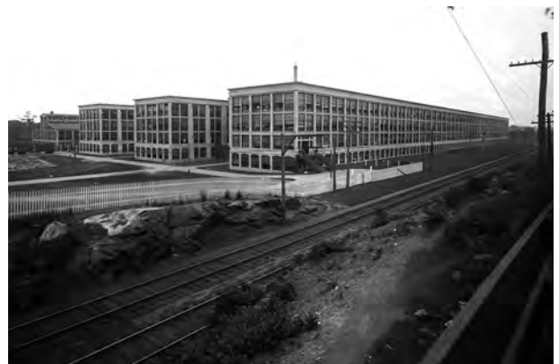
Fig. 1.27 - Ernest Leslie Ransome: United Shoe Machinery , Beverly, Massachusetts, 1903-06. Com aproximadamente 1900m 2 foi até 1937 a maior construção em concreto armado nos Estados Unidos. [Disponível em < http://www.cummings.com/timages/tracks.jpg > Acesso em 11 ago. 2003]
