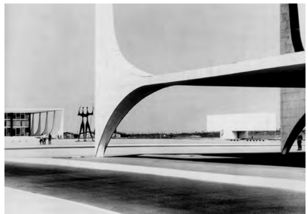
Fig. 4.422 - Oscar Niemeyer: Palácio do Planalto, Brasília, 1958-60. Vista lateral do encontro da laje com um dos pilares. [UNDERWOOD, 1994]:85
