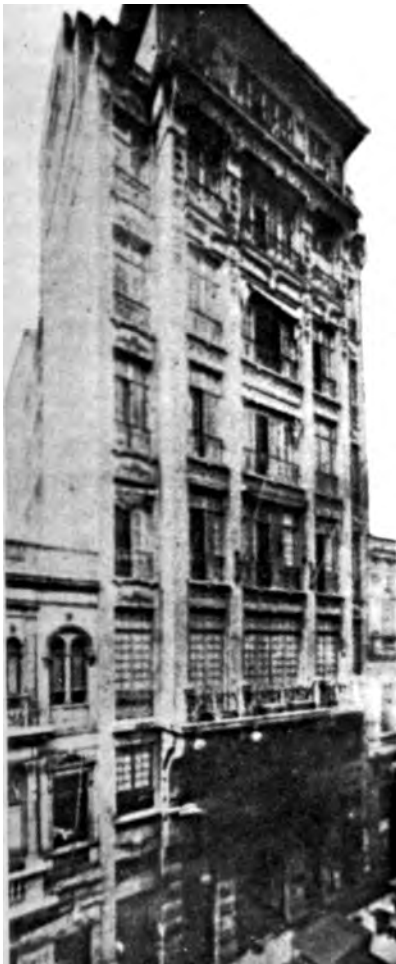
Fig. 1.79 - Hyppolito Pujol Junior (engenheiro): Edifício Guinle, São Paulo, 1913 (hoje Edifício Leônidas Moreira). [VASCONCELOS, 1985]:15b
