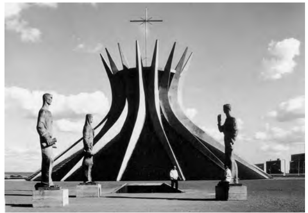
Fig. 4.451 - Oscar Niemeyer: Catedral de Brasília (nave principal), 1959-60. Vista do acesso. [UNDERWOOD, 1994]: 137
