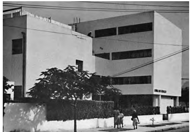
Fig. 4.67 - Oscar Niemeyer: Obra do Berço, Rio de Janeiro, 1937-42. Fachada leste do bloco de 4 pavimentos. [GOODWIN, 1943]:139
