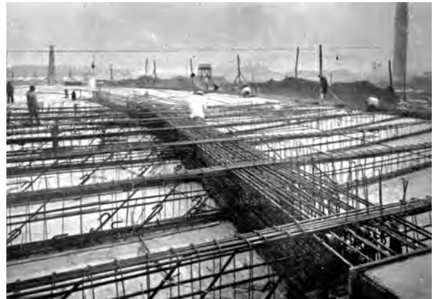
Fig. 4.315 - Oscar Niemeyer e equipe: Grande Marquise do Ibirapuera, São Paulo, 1951-55. Armadura longitudinal. [ACRÓPOLE nº185]:218
