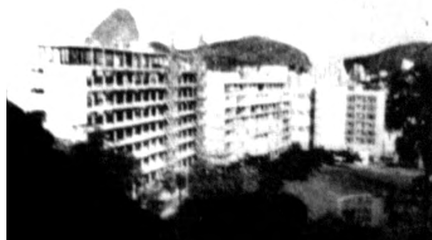
Fig. 4.208 - Lucio Costa : Parque Guinle, Rio de Janeiro, 1947-53. Em primeiro plano o edifício Caledônia em construção. [Revista Municipal de Engenharia, Out-Dez 1948]: 149-153
