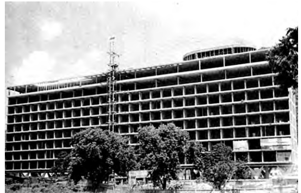
Fig. 4.350 - Oscar Niemeyer e Hélio Uchôa: Hospital Sul-América, Rio de Janeiro, 1952-59. Edifício em fase de construção. [PAPADAKI, 1956]:86
