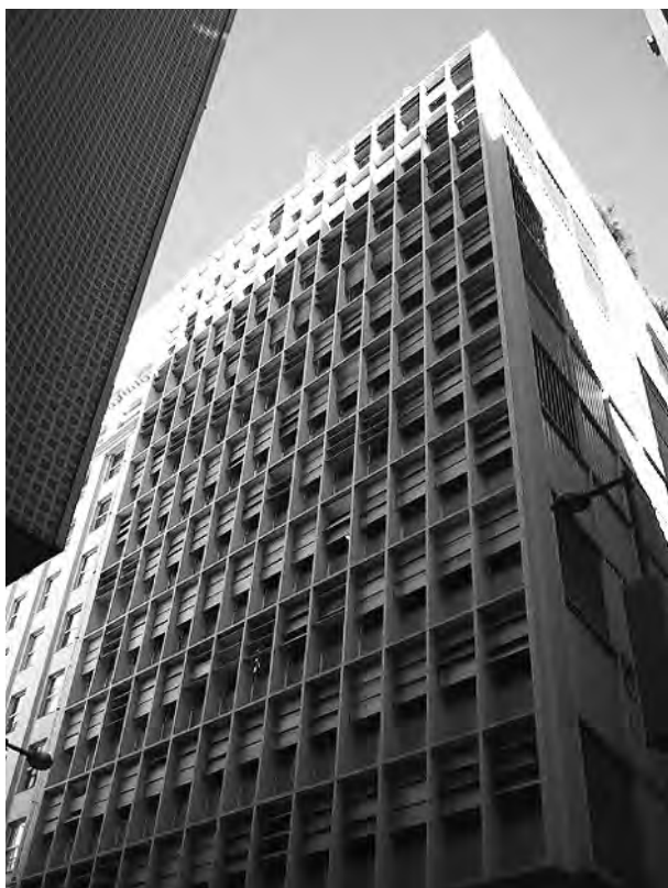
Fig. 4.183 - Oscar Niemeyer : Banco Boa Vista, Rio de Janeiro, 1946. As fachadas norte e oeste possuem uma grelha em concreto aplicada a estrutura do edifício. [FOTO DO AUTOR]
