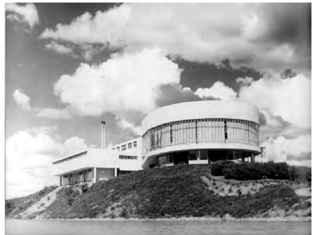
Fig. 4.102 - Oscar Niemeyer: Cassino da Pampulha, Belo Horizonte, 1940-42. Vista posterior do edifício a partir da lagoa. [UNDERWOOD, 1994]:53
