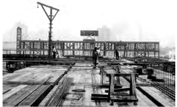
Fig. 4.79 - Marcelo e Milton Roberto: Aeroporto Santos Dumont, Rio de Janeiro, 1937-44. Vista da montagem das formas do corpo principal. [VESPUCCI, 1996]
