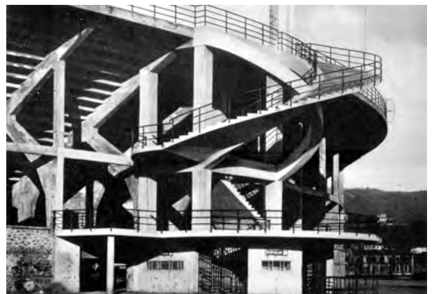
Fig. 2.08 - Pier Luigi Nervi: Estádio Municipal, Florença, 1929-32. Estrutura da escada helicoidal. [DESIDERI, 1982]:61
