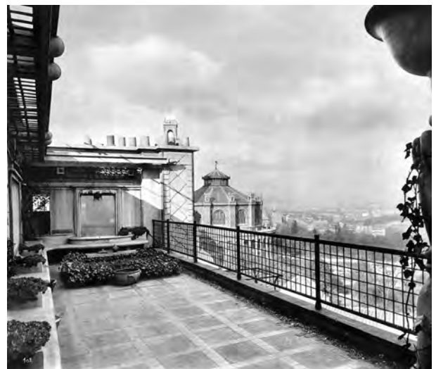
Fig. 1.44 - Auguste Perret: 25 bis da Rua Franklin, Paris, 1903-1905. Vista do terraço-jardim do 10º pavimento. [CHAMPIGNEULLE, 1959]:18
