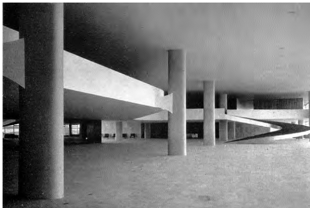
Fig. 4.432 - Oscar Niemeyer : Palácio do Planalto, Brasília, 1958-60. Detalhe interno da estrutura, com os consolos de seção variável. [AA nº 90, 1960]
