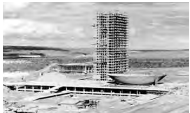
Fig. 4.436 - Oscar Niemeyer: Congresso Nacional, Brasília, 1956-60. As duas cúpulas já sem o cimbramento. [Arquivo Público do DF]
