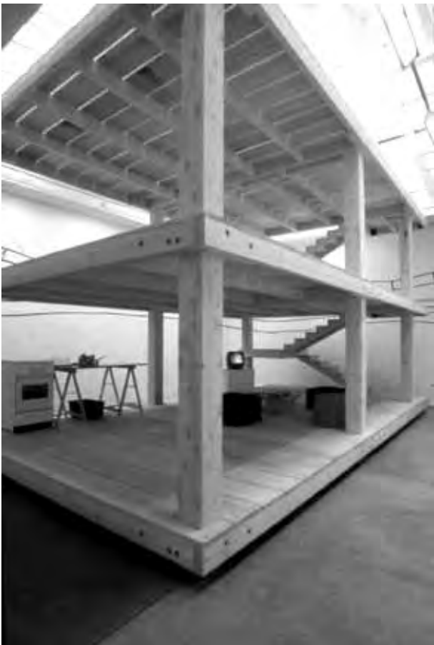
Fig. 3.26 - Maquete do casa Dom-ino em escala natural feita em madeira pelo escritório de Rirkrit Tiravanija, 1998. [Disponível em < http://www.crousel.com/tiravanija/images/rt-dom-ino.html > Acesso em 10 ago. 2003]
