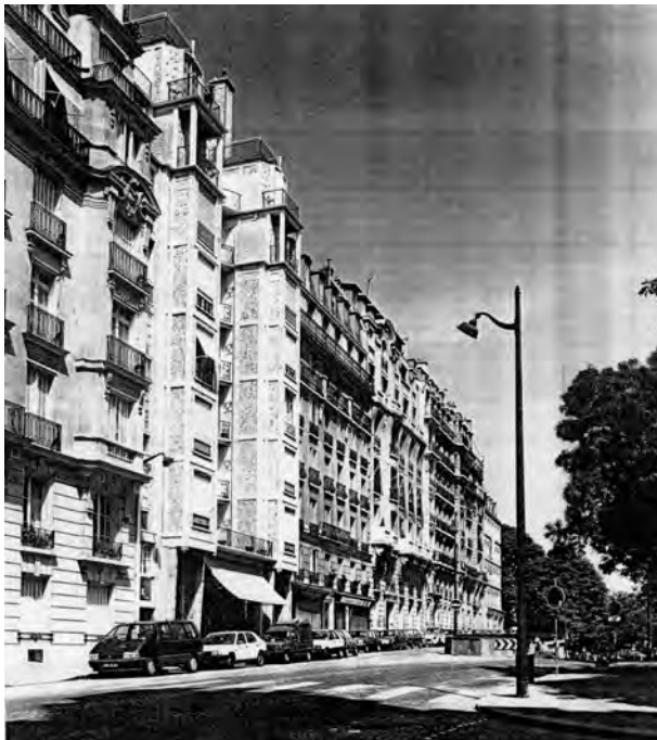
Fig. 1.36 - Auguste Perret: 25 bis da Rua Franklin, Paris, 1903-05. Em primeiro plano o edifício de apartamentos no contexto urbano e os recuos superiores exigidos por lei. [GARGIANI, 1994]:221
