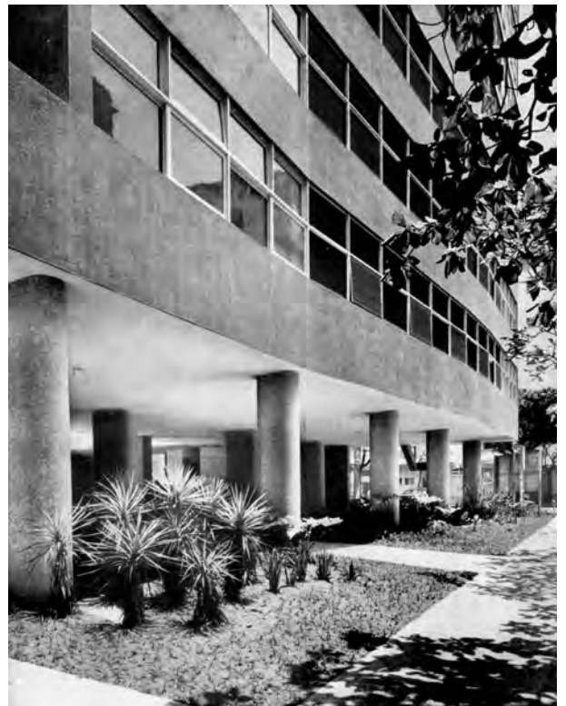
Fig. 4.346 - MMM Roberto: Edifício Finússia e Dona Fátima, Rio de Janeiro, 1952-54. Vista do nível de acesso, com o balanço ao fundo e o primeiro peitoril que esconde a laje dupla que sustenta os pavimentos-tipo. [Módulo, dez 1955]:36
