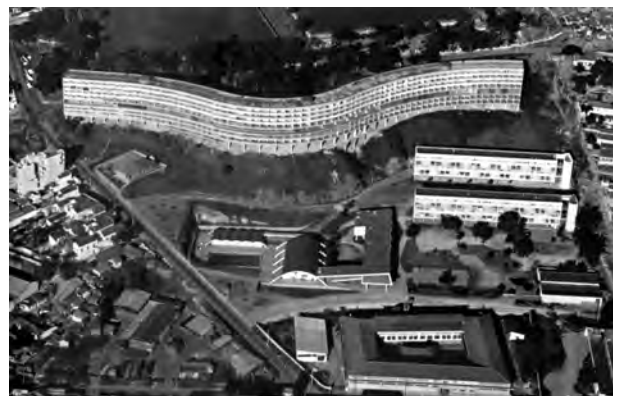
Fig. 4.216 - Affonso Eduardo Reidy: Conjunto Pedregulho, Rio de Janeiro, 1948-58. Vista aérea do conjunto. [REIDY, 1999]:89
