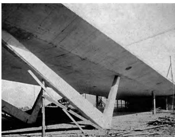
Fig. 4.311- Oscar Niemeyer e equipe: Grande Marquise do Ibirapuera, São Paulo, 1951-55. Vista dos pilares em "V". [ACRÓPOLE nº185]:217
