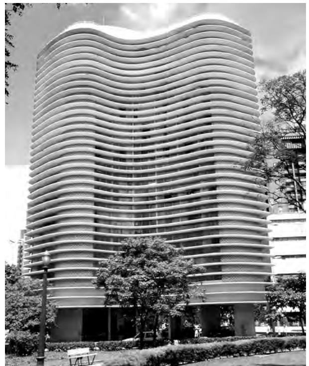
Fig. 4.390 - Oscar Niemeyer: Edifício Oscar Niemeyer, Belo Horizonte/MG, 1954-60. Fachada para a praça da Liberdade. [FOTO: MARCOS ALMEIDA, 2002]
