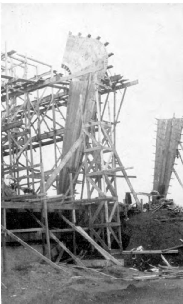
Fig. 4.254 - Oscar Niemeyer: Fábrica Duchen, São Paulo/SP, 1950-51. Montagem das formas do bloco industrial. [REVISTA POLITÉCNICA, nº 164]
