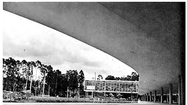
Fig. 4.308 - Oscar Niemeyer e equipe: Grande Marquise do Ibirapuera, São Paulo, 1951-55. Vista do balanço da marquise. [PAPADAKI, 1956]: 140
