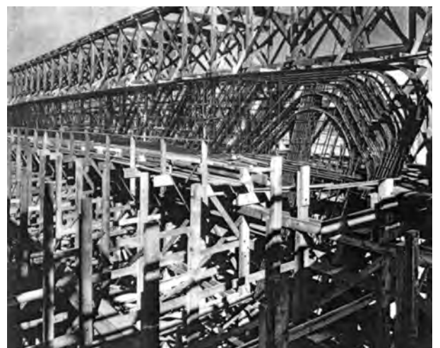
Fig. 4.374 - Affonso Eduardo Reidy: Museu de Arte Moderna, Rio de Janeiro, 1953-58/1967-68. Detalhe da armadura dos pórticos. [FRANCK & Giedion, 1960]: 77
