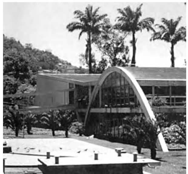
Fig. 4.351 - Oscar Niemeyer e Hélio Uchôa: Hospital Sul-América, Rio de Janeiro, 1952-59. Vista do arco estruturante do bloco administrativo. [PAPADAKI, 1956]:116
