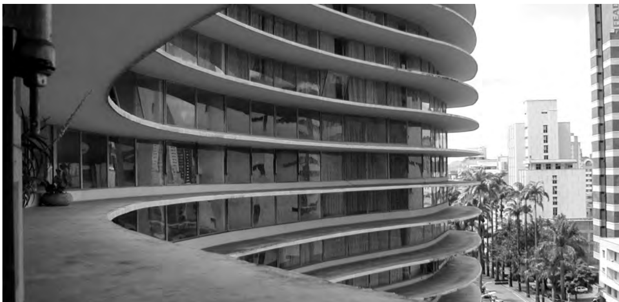
Fig. 4.402 - Oscar Niemeyer : Edifício Oscar Niemeyer, Belo Horizonte/MG, 1954-60. Vista dos brises a partir do volume da escada. [MACEDO, 2002]: fig 144m
