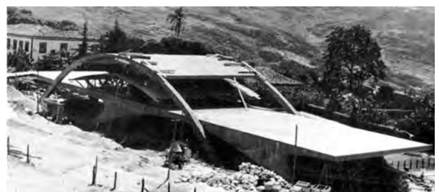
Fig. 4.238 - Oscar Niemeyer: Clube Diamantina, 1950. O clube em fase de construção. [PAPADAKI, 1956]: 112
