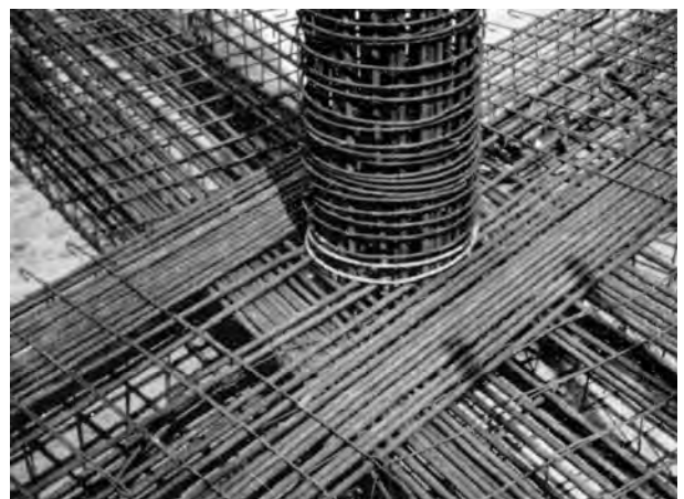
Fig. 4.279 - Oscar Niemeyer: Palácio das Indústrias (Parque do Ibirapuera), São Paulo, 1953. Detalhe da junção da coluna com duas vigas do piso intermediário. [ACRÓPOLE nº193]: 57
