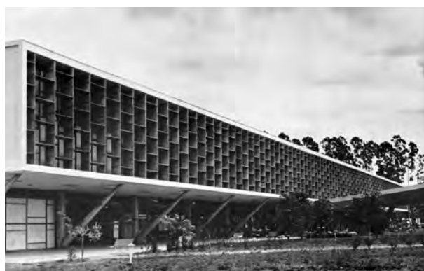
Fig. 4.264 - Oscar Niemeyer e equipe: Palácio das Nações e dos Estados (Parque do Ibirapuera), São Paulo, 1951-53. Vista a partir da grande marquise. [PAPADAKI, 1956]: 134
