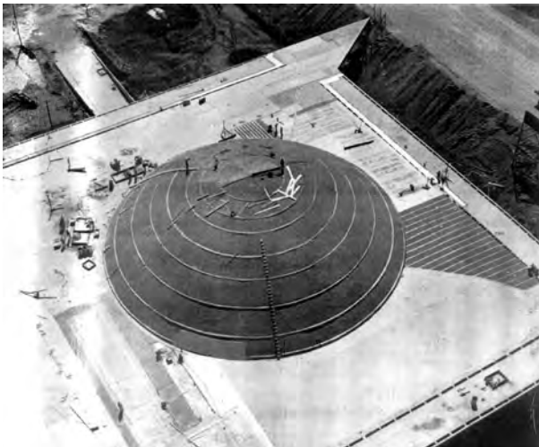
Fig. 4.448 - Oscar Niemeyer: Congresso Nacional, Brasília, 1956-60. Vista aérea do Senado, ainda nas armaduras e a impermeabilização da laje da esplanada. [BRASÍLIA nº 30]: 05
