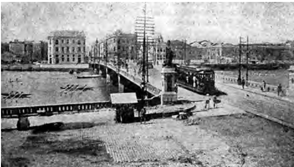
Fig. 2.24 - Emílio Baumgart : Ponte Maurício de Nassau, no Recife/PE, 1913. Primeira ponte feita em viga contínua e sem juntas de dilatação. [CONCRETO nº75 jun de 1945]:195
