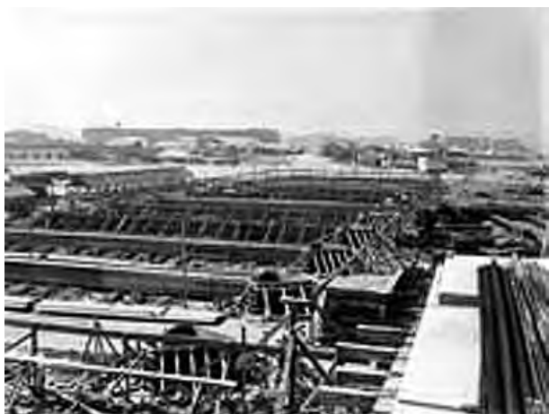
Fig. 4.383 - Vista superior da concretagem dos pórticos. [CENTRO DE PESQUISA E DOCUMENTAÇÃO - MAM]
