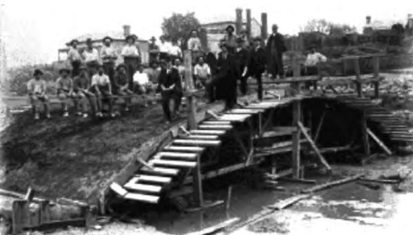
Fig. 1.17 - Booth Street Bridge, Bendigo, 22 jun 1901. Construída a partir do arco de Monier. [Disponível em < http://home.vicnet.net.au/~aholgate/jm/bltarchpics/booth_turning.gif > Acesso em 10 set. 2003]
