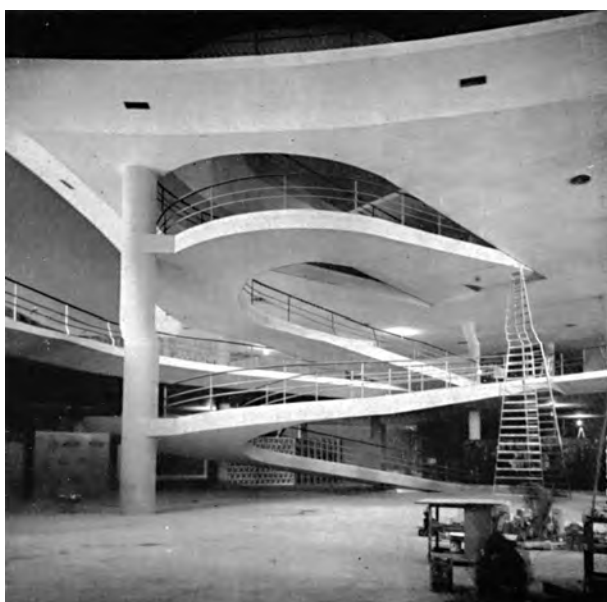
Fig. 4.298 - Oscar Niemeyer : Palácio das Artes (Parque do Ibirapuera), São Paulo, 1953-54. As rampas finalizadas e a coluna de apoio em primeiro plano. [ACRÓPOLE nº191]:494
