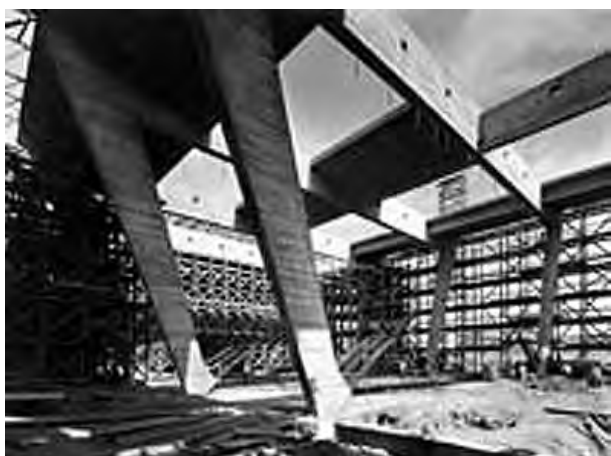
Fig. 4.384 - O esqueleto do museu em 1959, com as pernas menores do pórticos ainda nas ferragens. [CENTRO DE PESQUISA E DOCUMENTAÇÃO - MAM]
