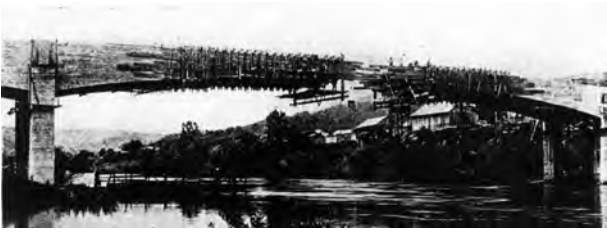
Fig. 2.28 - Emílio Baumgart : Ponte sobre o Rio do Peixe, em Erval /SC, 1930. Com vão de 68,5m foi construída totalmente livre de escoras. [Engineering News-Record, ago de 1931]:209
