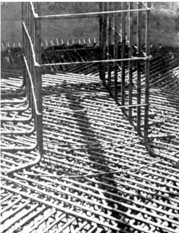
Fig. 2.41 - Antonio Alves de Noronha : Ministério do Trabalho, Rio de Janeiro. Detalhe da armação de uma das sapatas, com o diminuto espaçamento entre as barras de ferro. [CONCRETO nº10, jul de 1938]:9
