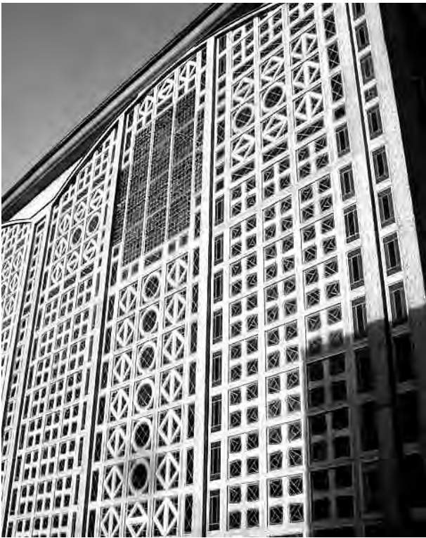
Fig. 2.03 - Auguste e Gustave Perret: Igreja Notre-Dame-de-la-Consolation em Le Raincy , 1922-23. Fachada lateral com os módulos de concreto e vidro, estruturados por grandes “montantes” verticais em concreto armado. [Disponível em < http://www.structurae.de/photos/raincy03.jpg > Acesso em 05 ago. 2003]
