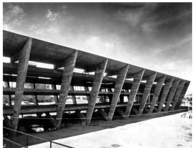
Fig. 4.369 - Affonso Eduardo Reidy : Museu de Arte Moderna, Rio de Janeiro, 1953-58/1967-68. Estrutura do bloco de exposições. [BONDUKY, 1999]: 174
