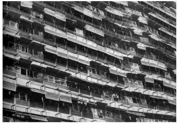
Fig. 4.341 - MMM Roberto: Edifício Marquês de Herval, Rio de Janeiro, 1952-1955. Fachada para a Av. Rio Branco. [BRUAND, 1981]:179
