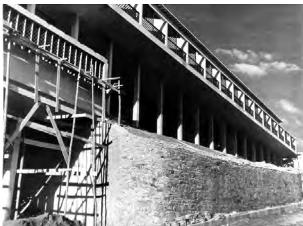
Fig. 4.101 - Oscar Niemeyer : Grande Hotel, Ouro Preto/MG, 1939-40. Hotel em construção. [COMAS, 2002]
