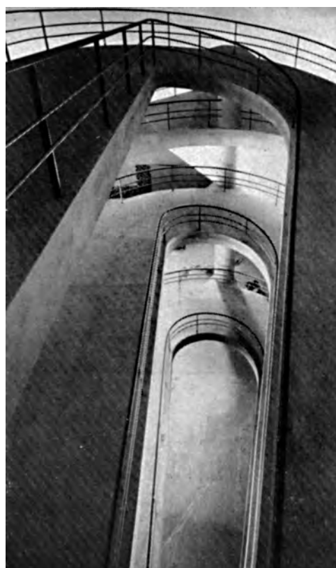
Fig. 4.301 - Oscar Niemeyer : Palácio das Artes (Parque do Ibirapuera), São Paulo, 1953-54. Vista dos níveis da rampa em forma de ferradura. [ACRÓPOLE nº191]:494
