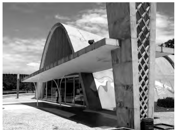
Fig. 4.150 - Oscar Niemeyer: Capela São Francisco de Assis, Belo Horizonte, 1944-45. Detalhe do encaixe de marquise no campanário. [COMAS, 2002]
