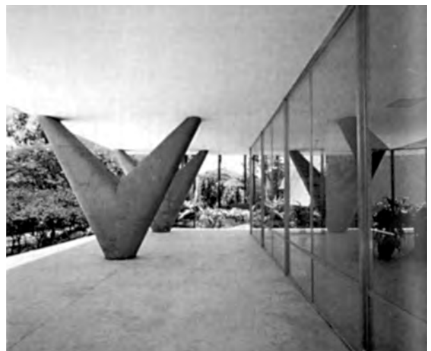
Fig. 4.355 - Oscar Niemeyer e Hélio Uchôa: Hospital Sul-América, Rio de Janeiro, 1952-59. Vista dos pilares em “V” perpendiculares à menor fachada. [BOTEY, 1996]:116
