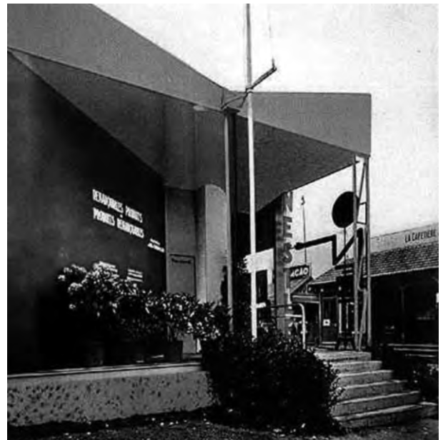
Fig. 3.43 - Le Corbusier : Pavilhão Desmontável Nestlé, Paris, 1928. Telhado “borboleta”. [FONDATION LE CORBUSIER. Le Corbusier: architecte/artiste . London: Inifinitum publications, 1997. CD-ROM. Macintosh]
