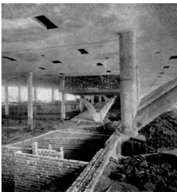
Fig. 4.271 - Oscar Niemeyer e equipe: Palácio das Nações e dos Estados (Parque do Ibirapuera), São Paulo, 1951-53. O edifício em construção: em primeiro plano, os apoios inclinados e a rampa ao fundo [ACRÓPOLE, nº185]: 215
