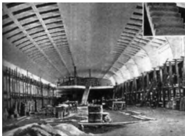
Fig. 4.251 - Oscar Niemeyer: Fábrica Duchen, São Paulo/SP, 1950-51. Vista interna na construção da estrutura de uma das naves do pavilhão industrial. [COLLARES, 2003]: 84
