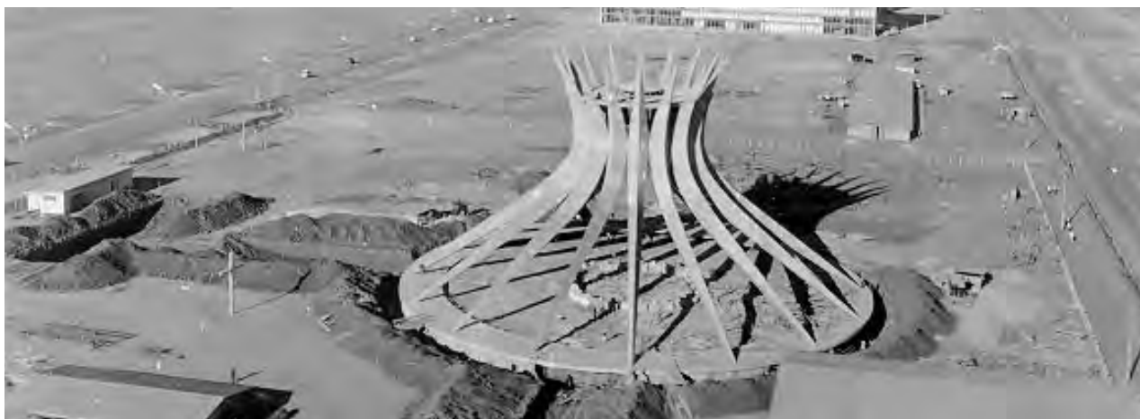
Fig. 4.461 - Oscar Niemeyer: Catedral de Brasília (nave principal), 1959-60. Vista aérea da estrutura e a escavação dos túneis de acesso. [Disponível em < http://www.geocities.com/TheTropics/3416/bw_cat.jpg > Acesso em 20 ago. 2003]
