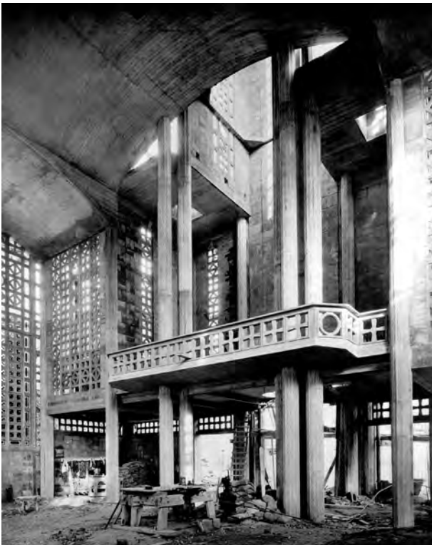
Fig. 2.04 - Auguste e Gustave Perret: Igreja Notre-Dame-de-la-Consolation em Le Raincy , 1922-23. Vista interna da igreja em obras, com colunas de dupla altura sustentando a laje do coro. [COHEN, 2002]: 178
