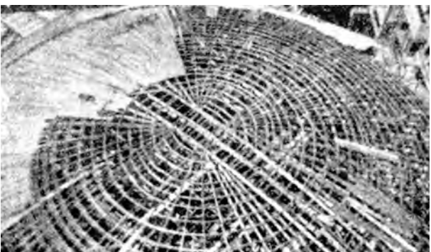
Fig. 2.30 - Emílio Baumgart : Cinema Roxy, Rio de Janeiro. Cúpula em fase de concretagem. [CONCRETO nº75 jun de 1945]:197
