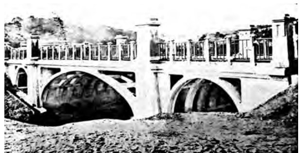
Fig. 1.78 - Guilherme E. Winter e Ernesto Chagas : Primeira obra em concreto armado em São Paulo, a Ponte da Cia. Mogyana em Socorro. Com 28m, foi inaugurada em 3 de maio de 1910. [VASCONCELOS,1985]: 15a
