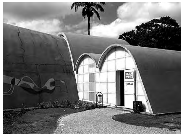
Fig. 4.156 - Oscar Niemeyer: Capela São Francisco de Assis, Belo Horizonte, 1944-45. Detalhe do encaixe das duas abóbadas que cobrem a sacristia. [COMAS, 2002]
