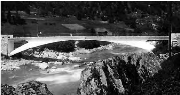
Fig. 1.52 - Robert Maillart: Ponte Tavanasa sobre o rio Rhine, Tavanasa, Graubünden/Grisons, Suíça, 1906. Nota-se uma evolução no sistema de arcos da ponte empregado anteriormente por Hennebique, com a eliminação dos pilares entre os arcos e as vigas de sustentação do plano da ponte. [Disponível em < http://dgcwww.epfl.ch/guide_des_ponts/images/tavana1.jpg > Acesso em 01 ago. 2003]
