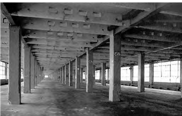
Fig. 1.68 - Giacomo Mattè-Trucco : Fábrica da Fiat, Turim, 1915-21. Vista da estrutura interna, com as vigas furadas na linha neutra. [Disponível em < http://www.lemeridien-lingotto.it/img/dentro-antico.jpg > Acesso em 05 ago. 2003]
