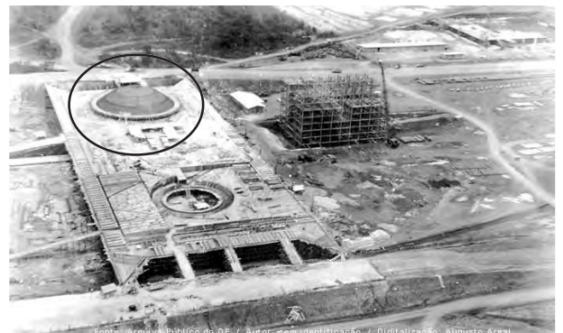
Fig. 4.445 - Oscar Niemeyer: Congresso Nacional, Brasília, 1956-60. Vista aérea com a cúpula do Senado recém concretada com o anel de borda exposto. [Arquivo Público do DF]
