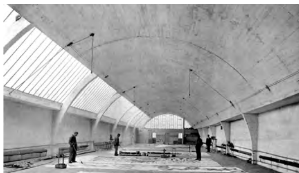
Fig. 4.249 - Auguste Perret: Ateliers de Décors , 1923. Cobertura de abóbada em concreto armado estruturada por arcos paralelos. [CHAMPIGNEULLE, 1959]: 36
