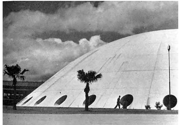
Fig. 4.285 - Oscar Niemeyer: Palácio das Artes (Parque do Ibirapuera), São Paulo, 1953-54, 1954. Vista parcial da cúpula de concreto. [PAPADAKI, 1956]:151
