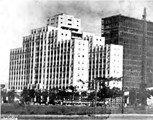
Fig. 2.40 - Antonio Alves de Noronha : Ministério do Trabalho, Rio de Janeiro. O edifício de 12 pavimentos foi visitado por Kleinlogel em 1937, juntamente com a obra do Ministério da Educação e Saúde Pública, ao fundo na fotografia. [CONCRETO nº10, jul de 1938]:8
