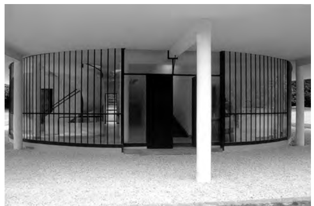
Fig. 3.37 - Le Corbusier: Villa Savoye , 1929-31. No pilotis, a esquadria é recortada para contornar o viga aparente. [KLICZOWSKI, 2003]:25
