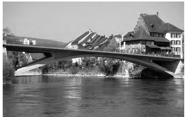
Fig. 4.236 - Robert Maillart: Ponte Aarburg (Argovia, Suíça), 1911. Os arcos que suportam planos como referência clara das experiências estruturais. [Disponível em < http://www.structurae.de/photos/pict0006.jpg > Acesso em 01 ago. 2003]
