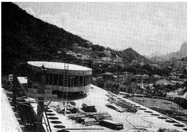
Fig. 4.357 - Oscar Niemeyer e Hélio Uchôa: Hospital Sul-América, Rio de Janeiro, 1952-59. Vista do terraço em construção. [PAPADAKI, 1956]:86
