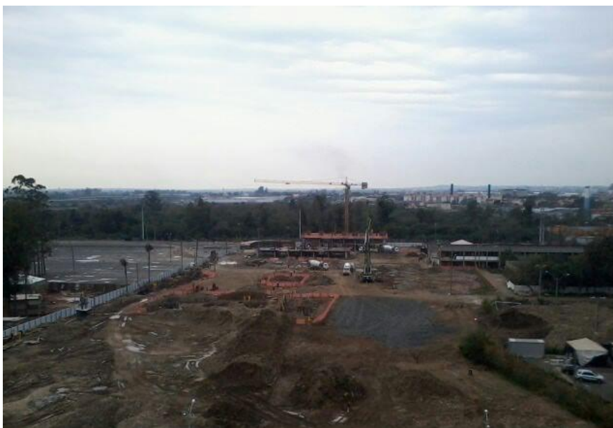
Figura 12 – Visão geral do canteiro de obras
