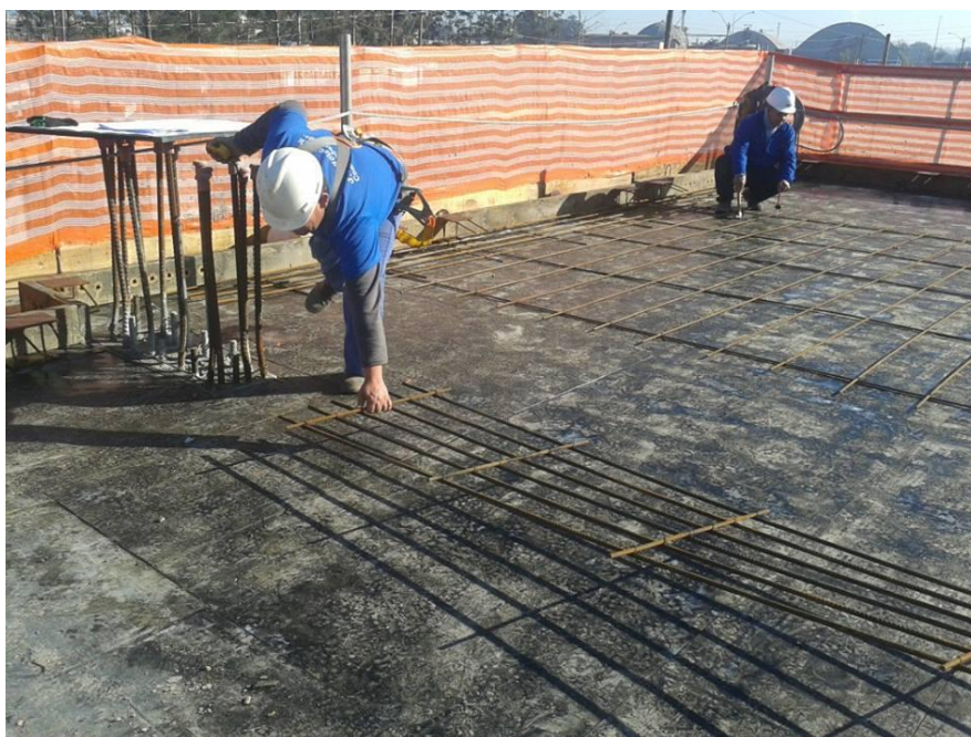
Figura 15 – Posicionamento da armadura positiva
