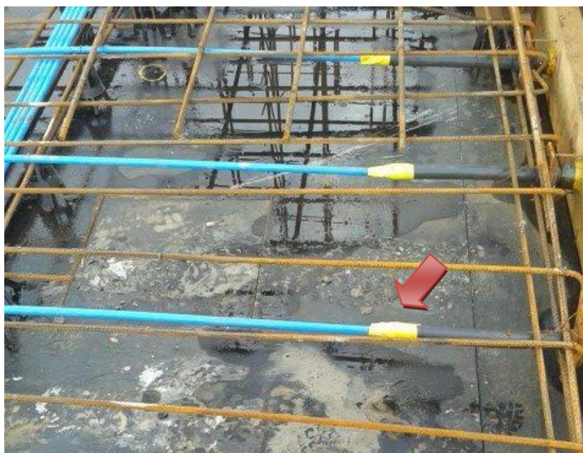
Figura 17 – Proteção da placa de ancoragem
