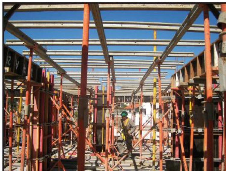
Figura 32 – Montagem do assoalho da laje
