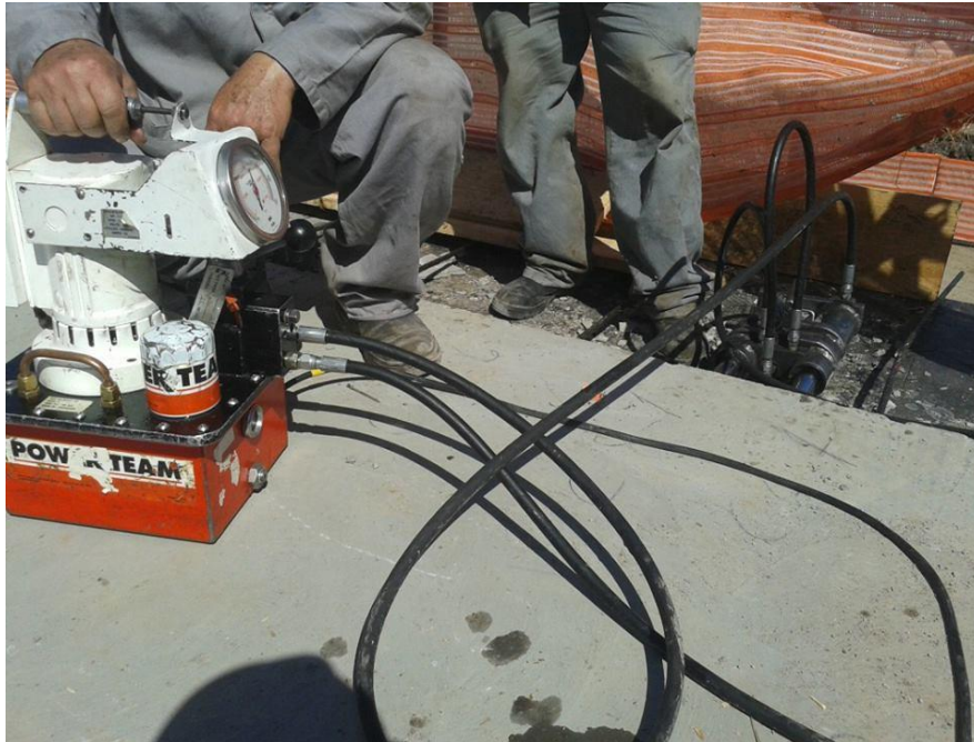
Figura 24 – Protensão das cordoalhas
