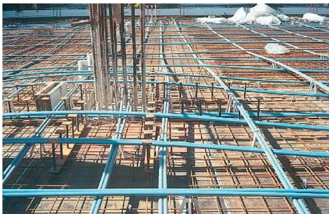
Figura 4 – Laje protendida por cordoalhas engraxadas
