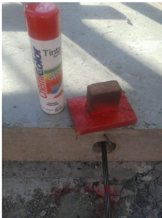
Figura 23– Marcação das cordoalhas
