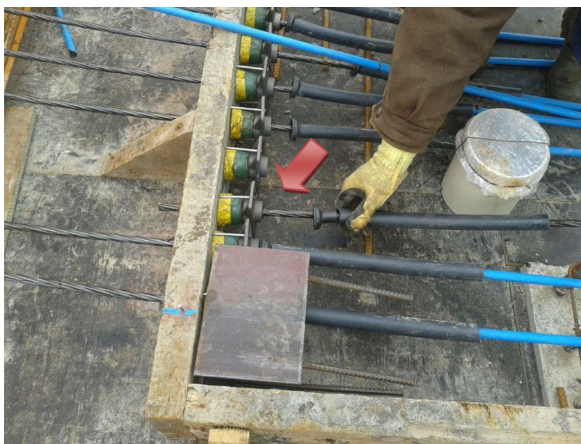
Figura 16 – Montagem da extremidade ativa
