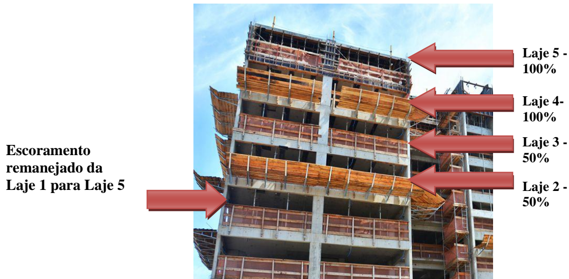
Figura 34 – Reescoramento do Sistema Convencional
