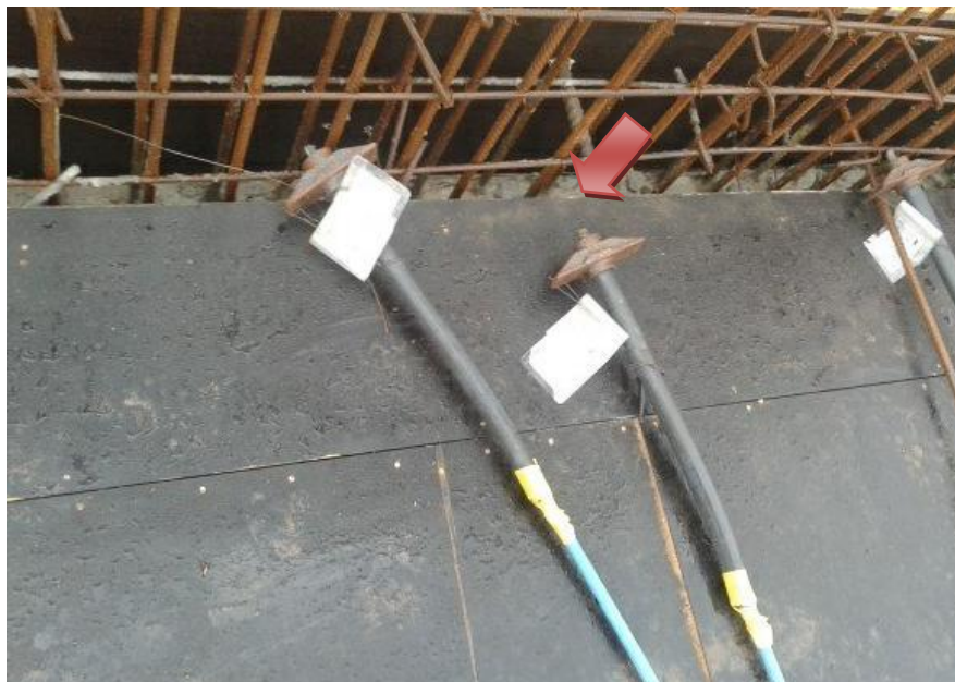
Figura 18 – Ancoragem Passiva Antes da Montagem
