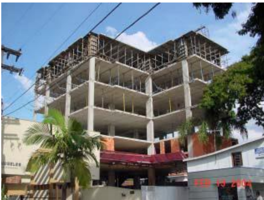
Figura 11 – Estrutura utilizando laje lisa
