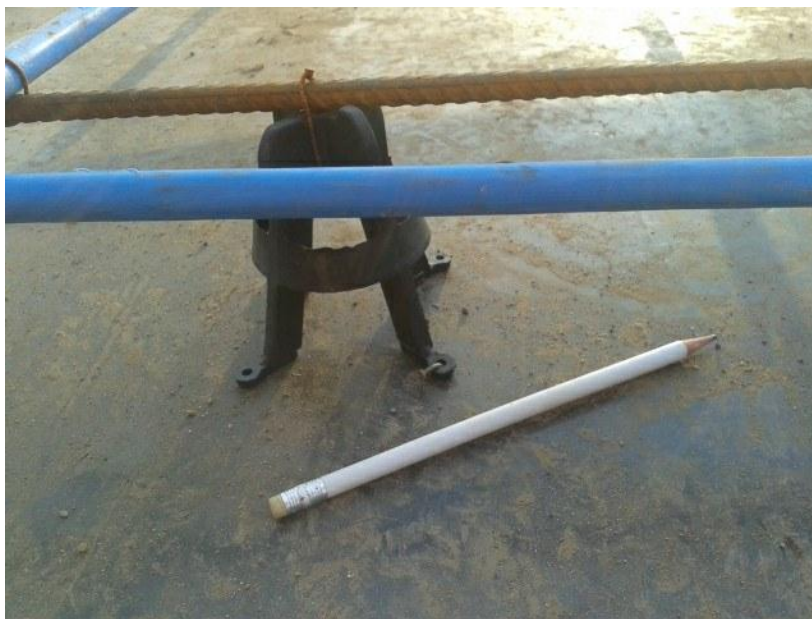
Figura 19 – Cadeira de apoio para cordoalha
