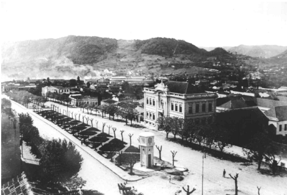
Figura 98: canteiro central da Av. Rio Branco, em 1925, com o poço tubular de 35 m de profundidade e o reservatório no mesmo local, oferecidos ao Município pelo Snr. Carlos Martins Peixoto e sua esposa. O reservatório fornecia água para irrigação dos canteiros e para o bebedouro público. A edificação de dois pavimentos é a da Escola de Artes e Ofícios Hugo Taylor da Cooperativa dos Empregados da Viação Férrea do Rio Grande do Sul, antes da construção das duas alas laterais. Acervo da Casa de Memória Edmundo Cardoso, foto de Venâncio Schleiniger.
