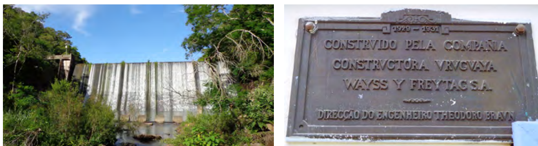
Figura 122 e 123: a primeira figura é a barragem acumuladora no ano de 2012, foto do autor. Antes da enxurrada que houve em maio de 1984 (MAGNA, 1984), que destruiu parte dela, havia uma passagem por cima da queda d'água, ligando uma extremidade à outra, como nas duas figuras anteriores. A segunda figura é a placa em metal que estava fixada na barragem, identificando a empresa que a construiu, engenheiro responsável pela obra e período, de 1929 a 1931, foto do autor em 2012. Atualmente, a placa encontra-se fixada em uma parede dentro da edificação da antiga estação de tratamento.
