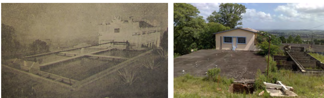
Figura 112 e 113: antigos tanques de decantação e edificação da estação de tratamento em duas épocas. A primeira figura (ABREU, P., 1953) é o projeto original e a segunda é a mesma estrutura adaptada e já com outra função em 2008 (CORSAN).
