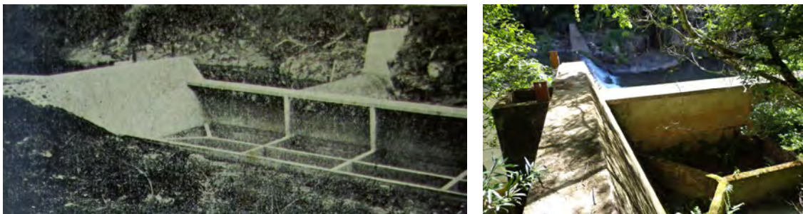
Figuras 124 e 125: a primeira figura (CCA, 1931) é a represa de tomada com os tanques de sedimentação, primeira etapa do tratamento d'água antes de entrar para adutora. A segunda figura é a represa, em 2012, já desativada devido à construção da barragem em Val de Serra, foto do autor.
