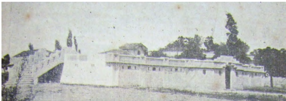
Figura 131: reservatório R 3 (CCA, 1931) antes da construção da Praça Saturnino de Brito.
