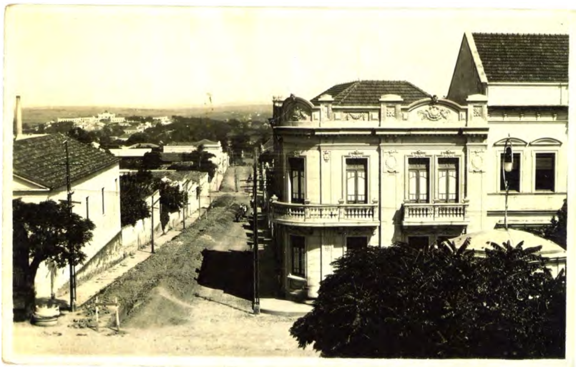
Figura 119: obras de saneamento na Rua dos Andradas, equina com a Av. Rio Branco. Acervo Casa de Memória Edmundo Cardoso.
