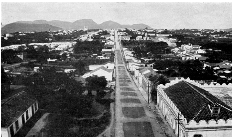
Figura 102: Rua do Comércio em fotografia tirada da edificação do 7º RI na Av. Borges de Medeiros em direção ao centro da cidade, acervo da Casa de Memória Edmundo Cardoso. A cada um ou mais terrenos, era feita uma faixa de calçamento atravessando a rua e unindo as sarjetas. No trecho da rua mais próximo do centro, ao fundo da imagem, a via já é toda calçada.
