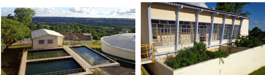
Figura 114 e 115: estrutura da antiga estação de tratamento adaptada para tratar a água proveniente da lavagem dos filtros de areia do sistema de tratamento atual. A segunda figura são os filtros de areia desativados da antiga estação já provenientes de outras adaptações. Fotos do autor em 2013.
