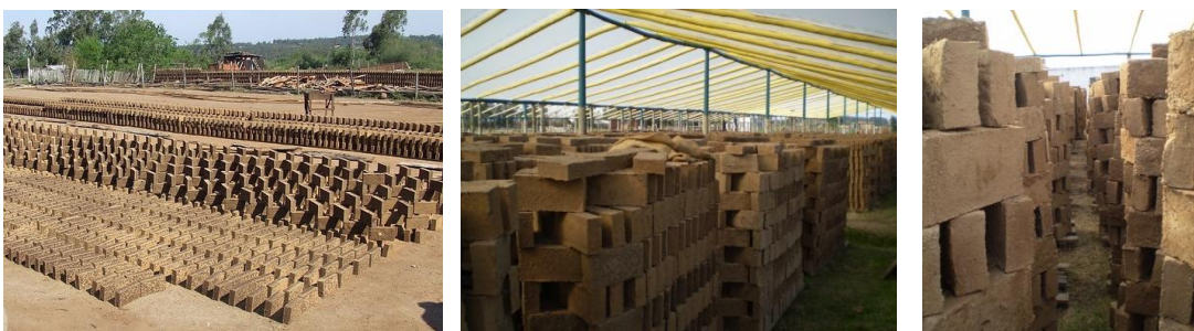
Figura 35: Secadero Ladrilleros de Rivera (Intendencia de Rivera) Figuras 36 y 37: Secadero LGP
