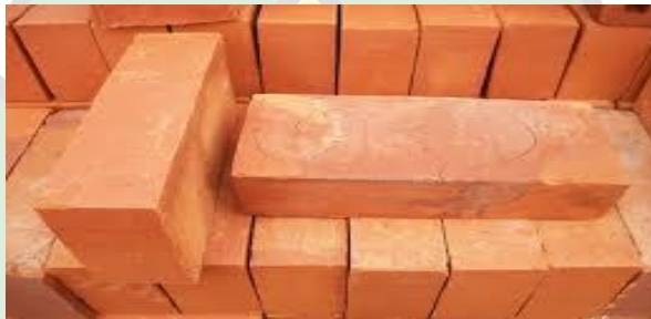
Gambar 2.5. Batu bata dibuat dari tanah Sumber: https://batamerahputih.wordpress.com
