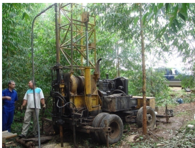
Figura 4.6: Perfuratriz Sullivan 22 usada para a execução dos furos de sondagem.
