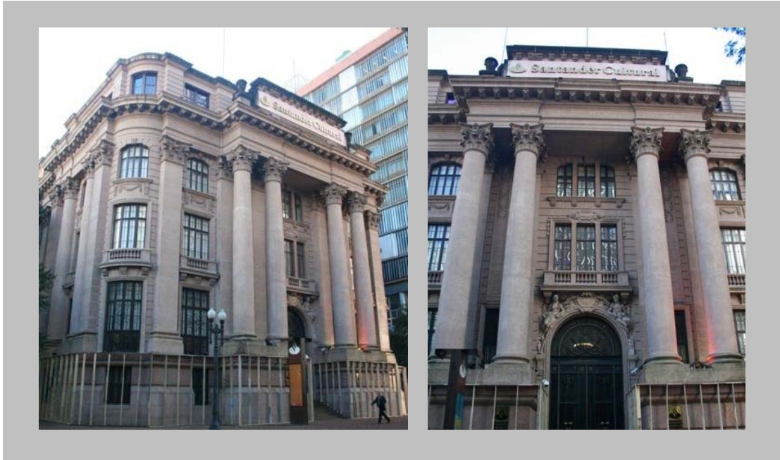
FIGURA 4.1 – FACHADA PRINCIPAL DO SANTANDER CULTURAL Fotos: Ricardo Calovi
