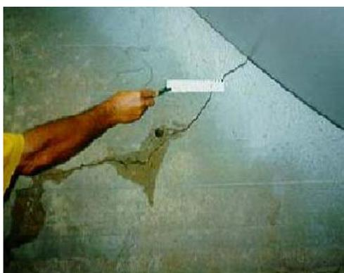
Figura 7: Detalhe da fissura em bloco de apoio do conduto forçado.
