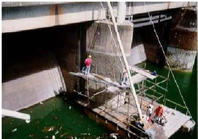
Figura 16: Projeção de argamassa na face dos pilares a montante do vertedouro.
