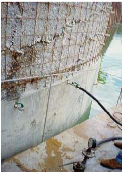
Figura 15: Tela metálica e posicionamento de tubos de pvc para injeção de calda nas fissuras do pilar a montante do vertedouro.
