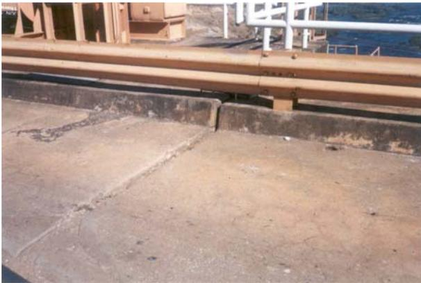
Figura 9: Desnívelamento entre juntas e fissuras superficiais (vertedouro / muro de transição).
