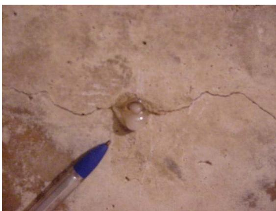
Figura 28: Detalhe de gel exsudando a partir de uma fissura na superfície do concreto.
