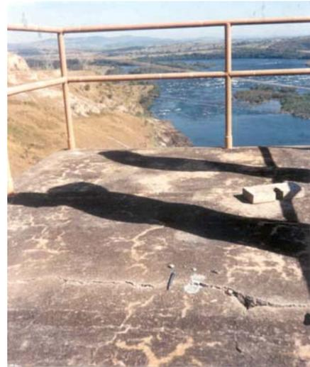
Figura 12: Fissura abrangendo toda a seção transversal do pilar.
