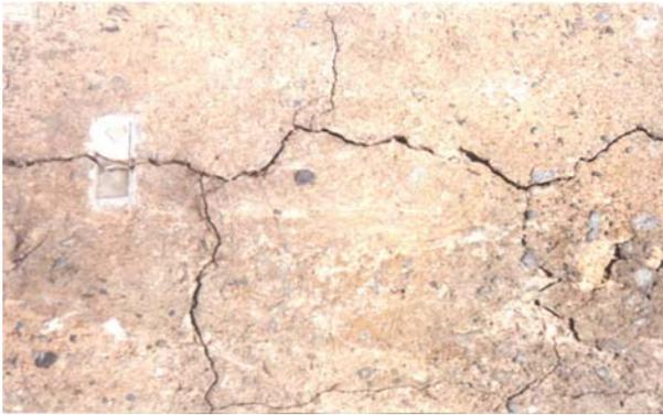
Figura 11: Detalhe das fissuras mapeadas no topo do pilar.
