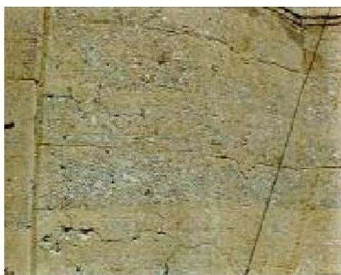
Figura 8: Detalhe das fissuras na lateral de um pilar do vertedouro – sentido montante.
