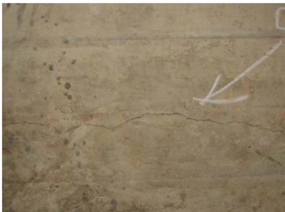
Figura 26: Detalhe de fissura horizontal na superfície do concreto.
