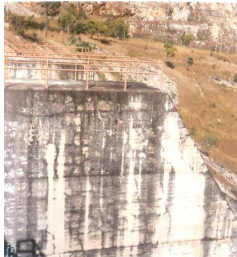
Figura 13: Fissuras na face lateral do pilar n.6, sentido jusante.
