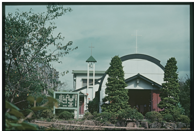
fig.14. 1959年頃のフランクのカラーズライド かまぼこ兵舎を利用して建てられた仮聖堂 The temporary church building in Ito, made by adapting a Quonset Hut (c. 1959) (From a colour slide by Frank)
