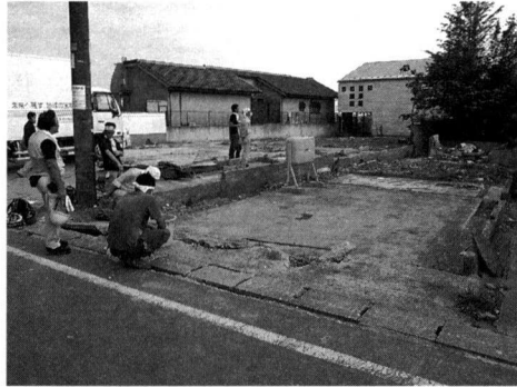
写真5 右図でみられる作業場のブルーシートは、倒壊後、片付けられた隣家の基礎の上に敷かれていて、作業が片付くと、コンクリートの基礎が現れる
