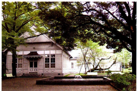
口絵 4. 北別館 (現史料館・旧図書館) [明治42年(1909)竣工]
