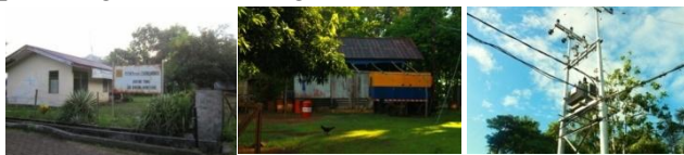
Gambar 9 kantor PLN,Mesin dan gardu Listrik : Sumber : observasi lapangan
