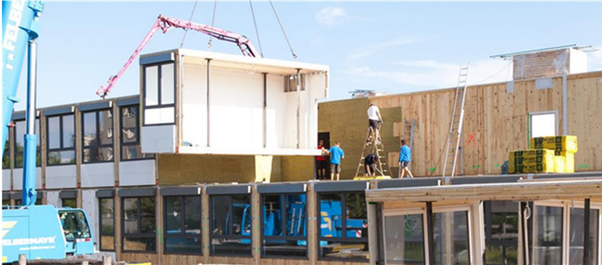
Kuva 14. Elementtikoulu valmistuu Wienissä. (Stora-Enso 2017)
