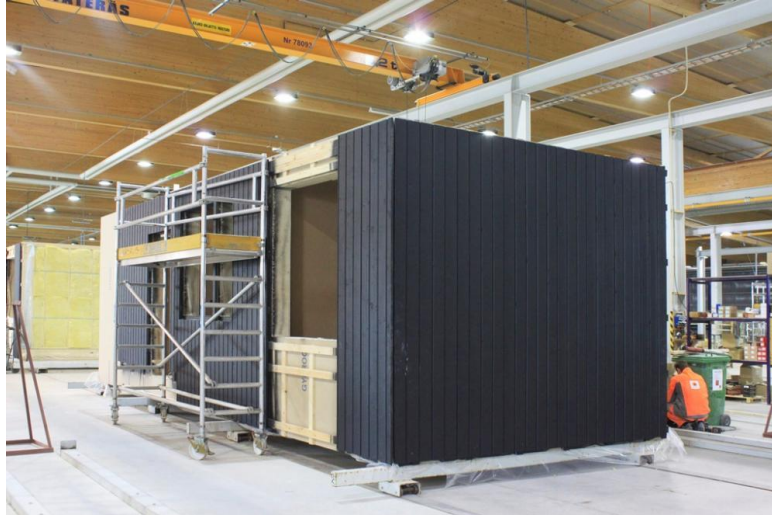
Kuva 12. Stora Enson tehtaalla valmistuva tilaelementti. (Puuinfo 2016. Tilaelementtirakentaminen).
