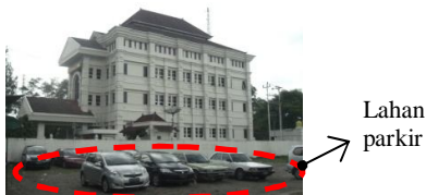
Gambar 8. Ruang Luar Barat Daya Benteng untuk Parkir
