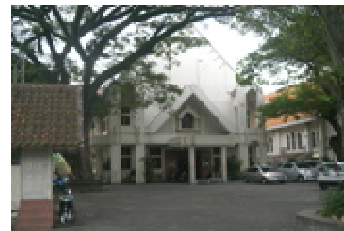
Gambar 4. OI Bangunan Kantor Gereja St. Antonius.
