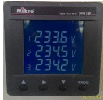
Gambar 16. Tampilan Alat Ukur untuk Nilai Tegangan per fasa tanggal 20 Juli 2016 pada Pukul 11:00 untuk Fasa I L1
