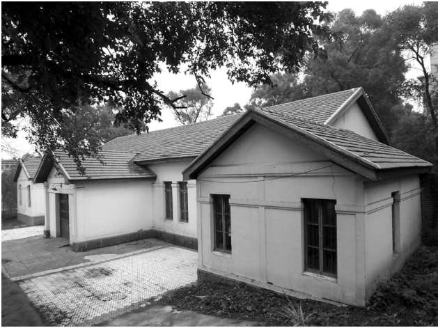
写真12 旧満洲国西安（現遼源）に建てられた西安神社。もと入母屋造の拝殿が切妻造に改変されている。両脇に突き出た部分は後補。
