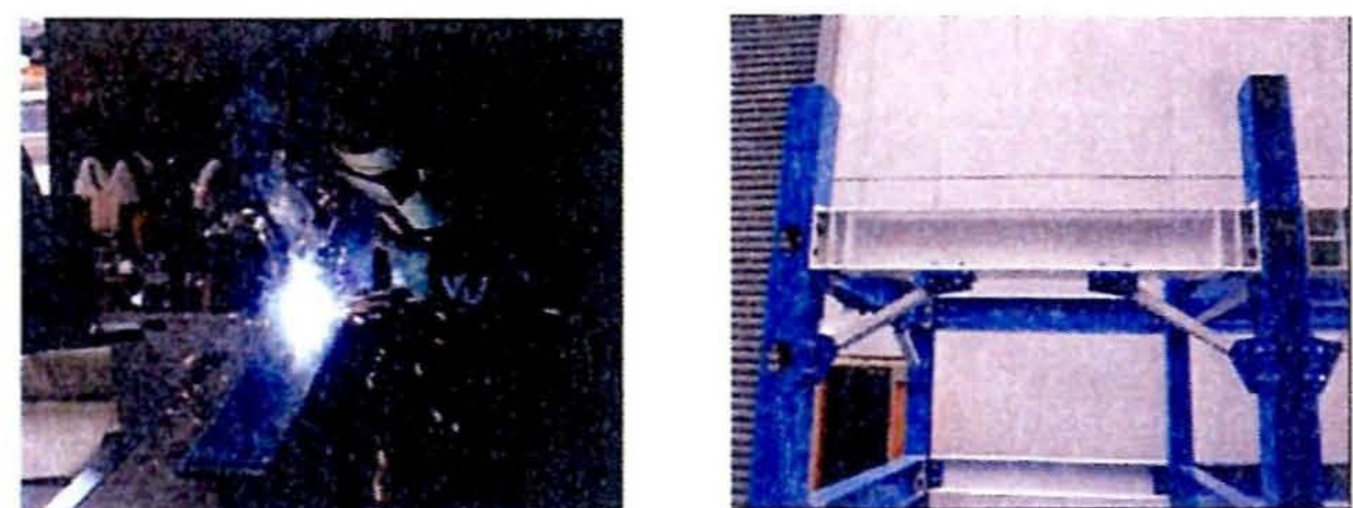
(a) 部材継溶接
