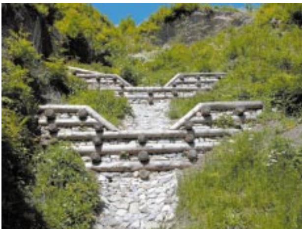
Figura 9. Sistemazione di un torrente con briglie di legno e pietrame.
