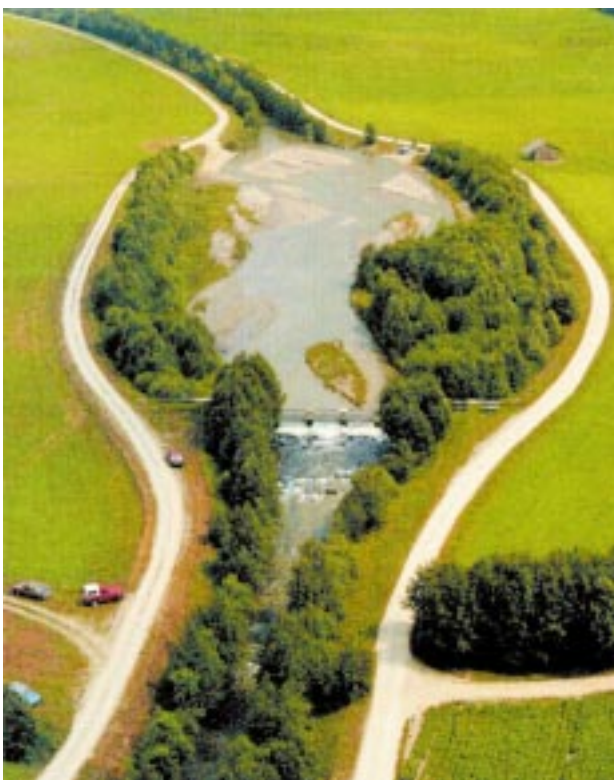
Figura 10. Rio Anteselva (BZ): piazza di deposito con creazione di una zona umida.
