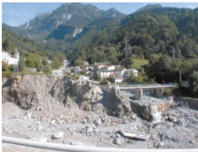
Figura 5. Pietratagliata (UD). Evento alluvionale del fiume Fella, agosto 2003: l'erosione dell'alveo e delle sponde ha provocato l'interruzione dell'unica strada di accesso al paese.
