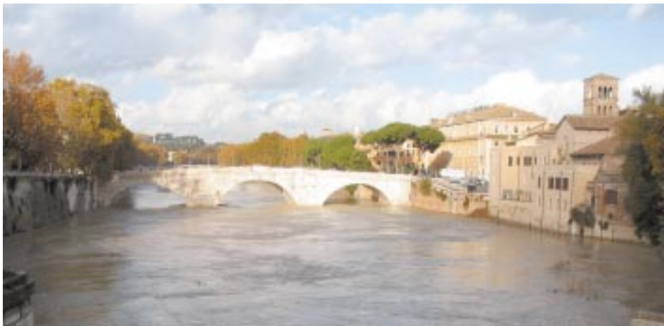
Figura 1. Roma, fiume Tevere, piena del 28/11/2005. Per evitare le periodiche inondazioni della città storica furono costruiti, a partire dal 1876, dei grandi muraglioni di contenimento del Tevere nell'attraversamento della città di Roma. Ciò determina, nei periodi di piena, un innalzamento del livello del fiume. Tale innalzamento viene tenuto sotto controllo dalla diga di Castel Giubileo posta a monte della città.
