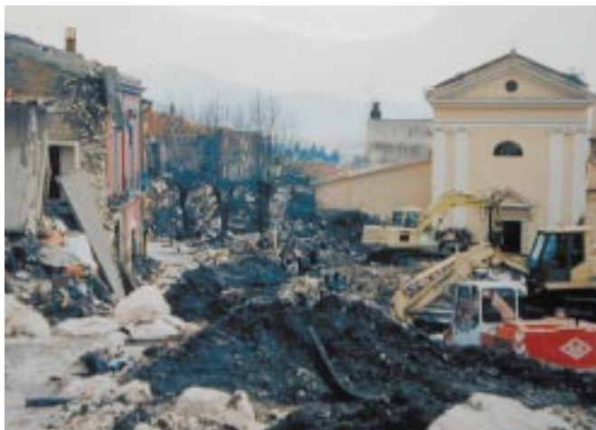
Figura 4. Cervinara (AV). Evento alluvionale del dicembre 1999: l'esondazione del torrente fu provocata dalla ostruzione di un ponticello all'altezza dell'abitato della frazione Castello.
