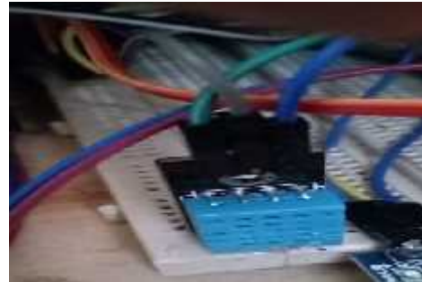
Gambar 18. Sensor Suhu dan Kelembaban DHT 11 pada Maket Rumah Pintar
