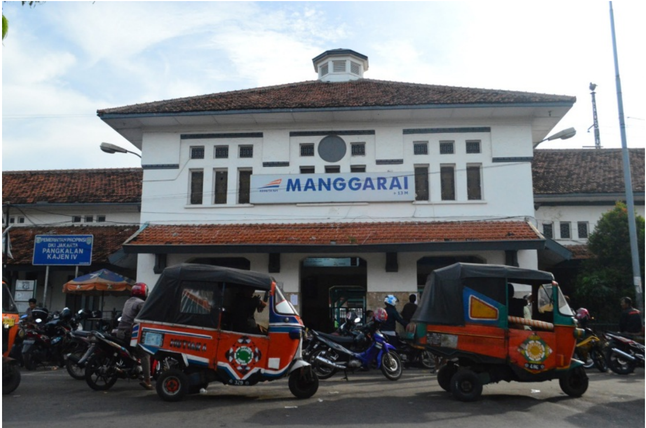
Gambar 1 Stasiun Manggarai, sumber: google.co.id
