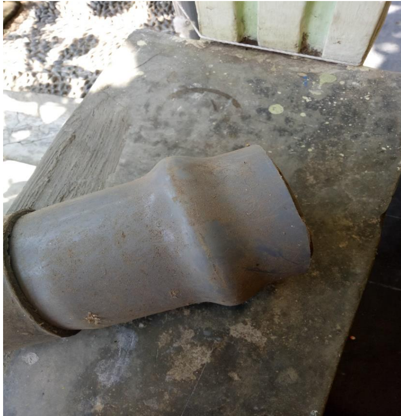
Gambar 5 Sambungan Pipa Menggunakan Shield
