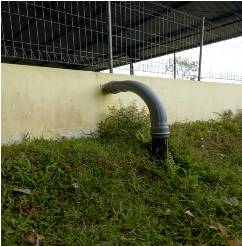
Gambar 4 Pipa Pembuangan Jika Air Melebihi Ketinggian 4,2m
