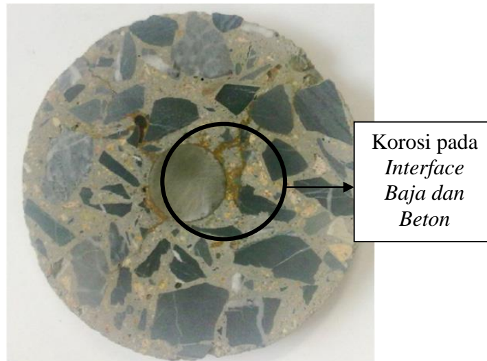
Gambar 2.2 Korosi yang Terjadi pada Interface Baja dan Beton (Zhao et al., 2012)
