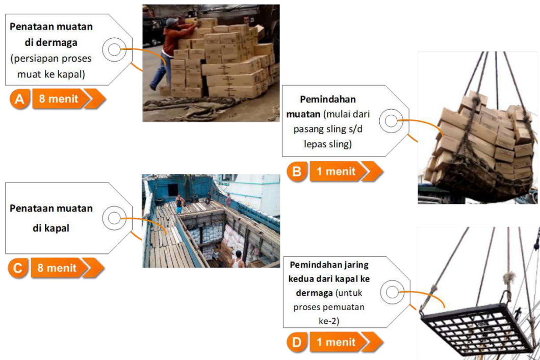
Gambar 4-7 Detail Pemuatan menggunakan Derek Kapal
