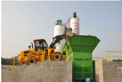
Gambar 4.4 Wheel Loader dalam Pekerjaan Produksi Beton di Batching Plant
