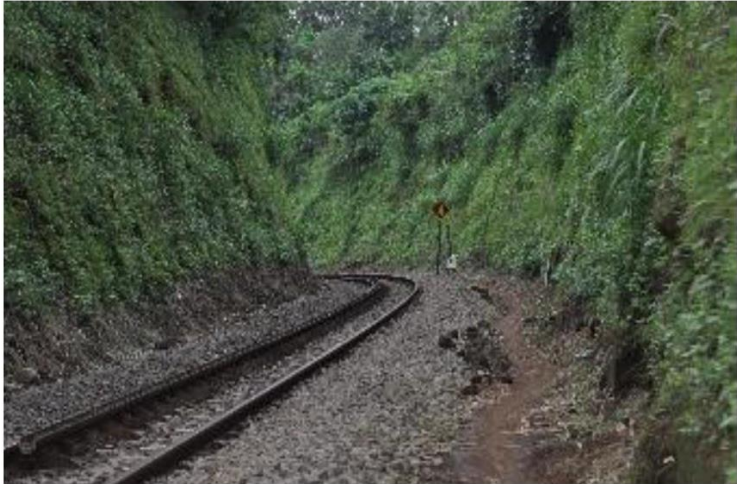
Gambar 5.18 Lokasi STA KM 25+100, menghadap kearah Banyuwangi
