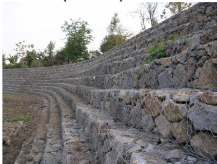
Gambar 2.11 Penggunaan bronjong sebagai dinding penahan tanah
