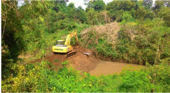
Gambar 4. 26 Pengelakan Sungai dalam keadaan di bendung/ checkdam di lapangan Sumber : Dokumentasi PT. Pandu Putra Primatama
