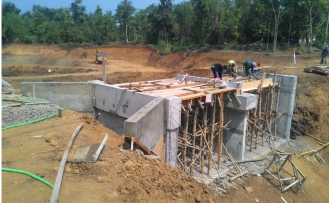
Gambar 4. 99 Pemasangan Bekisting pada Jembatan Sumber : Dokumentasi PT. Pandu Putra Primatama
