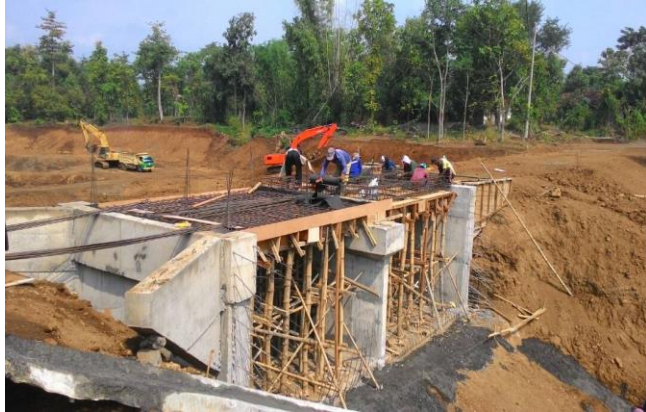
Gambar 4. 101 Penulangan Jembatan Sumber : Dokumentasi PT. Pandu Putra Primatama
