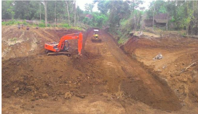
Gambar 4. 52 Persiapan Pembuatan Tubuh Embung dari CE AS0 hingga CE AS4
