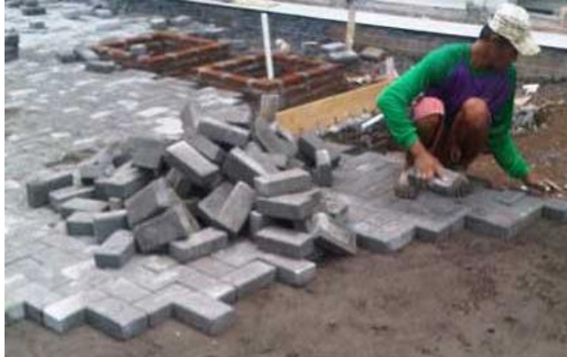
Gambar 4. 107 Pemasangan Paving Block Sumber : Dokumentasi PT. Pandu Putra Primatama
