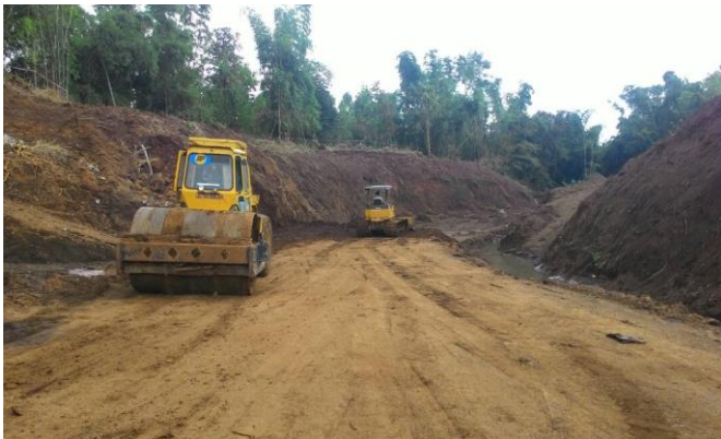
Gambar 4. 67 Pematatan untuk mencapai tinggi 4 meter Sumber : Dokumentasi PT. Pandu Putra Primatama
