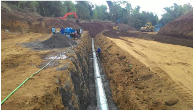
Gambar 4. 62 Pemasangan Pipa Outlet
