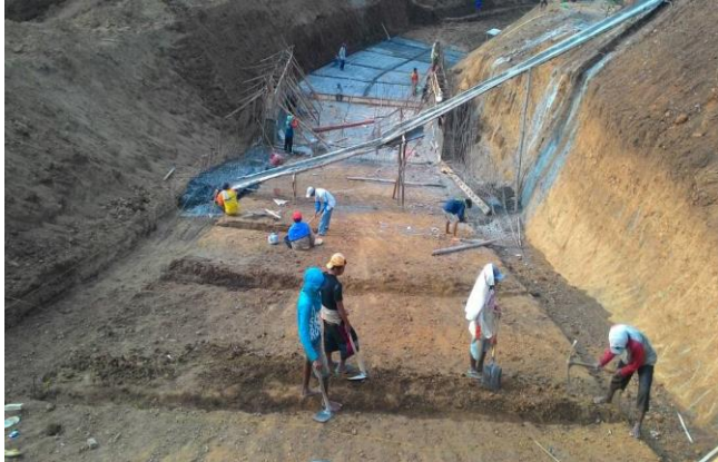
Gambar 4. 83 Galian untuk pemasangan sloope Sumber : Dokumentasi PT. Pandu Putra Primatama
