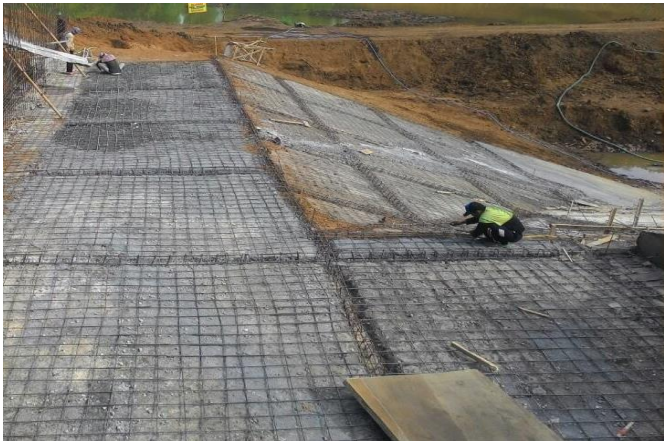
Gambar 4. 76 Gambar penulangan pada plat flood protection
