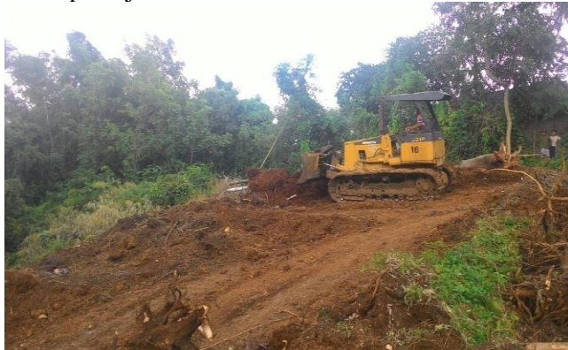
Gambar 4. 55 Perataan dengan tebal 40cm Sumber : Dokumentasi PT. Pandu Putra Primatama
