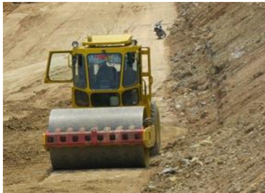
Gambar 4. 61 Melakukan kembali pemadatan dan timbunan Sumber : Dokumentasi PT. Pandu Putra Primatama
