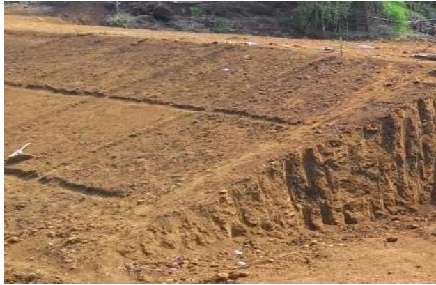
Gambar 4. 73 Galian untuk pemasangan tulangan sloof Sumber : Dokumentasi PT. Pandu Putra Primatama
