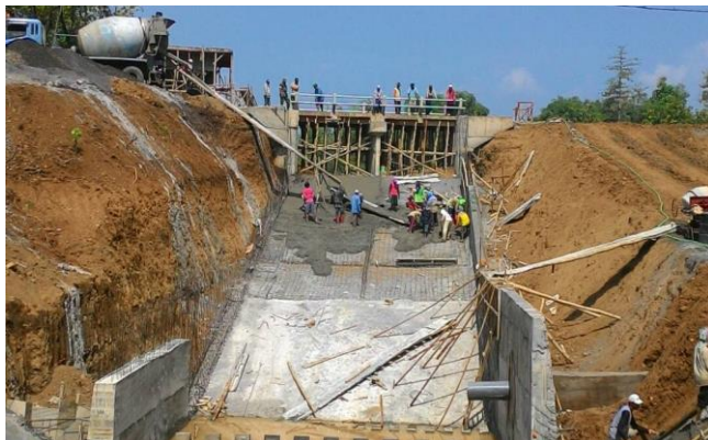
Gambar 4. 88 Proses Mulai Pengecoran pada Pelimpah Sumber : Dokumentasi PT. Pandu Putra Primatama
