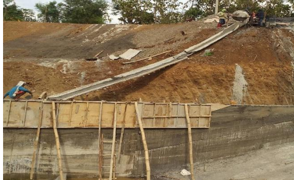
Gambar 4. 92 Pengecoran Dinding Pelimpah Sumber : Dokumentasi PT. Pandu Putra Primatama
