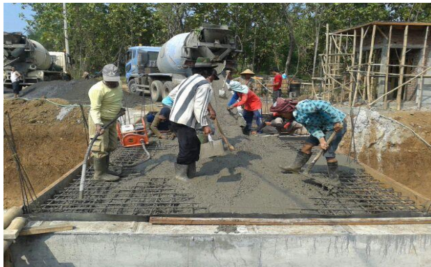
Gambar 4. 102 Pengecoran Jembatan Sumber : Dokumentasi PT. Pandu Putra Primatama
