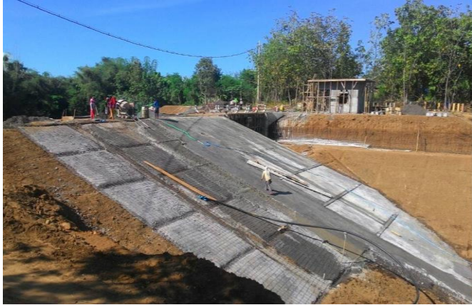
Gambar 4. 77 Pengecoran pada Slope Protection Sumber : Dokumentasi PT. Pandu Putra Primatama
