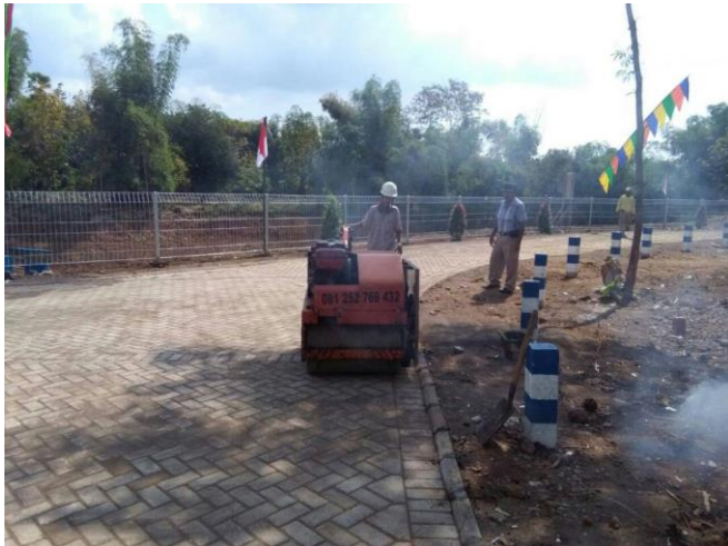
Gambar 4. 108 Pemasangan Paving Block Sumber : Dokumentasi PT. Pandu Putra Primatama
