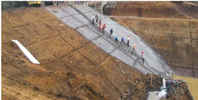
Gambar 4. 74 Pengecoran Lantai Kerja Sumber : Dokumentasi PT. Pandu Putra Primatama
