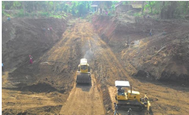
Gambar 4. 53 Proses Mulai Pematatan
