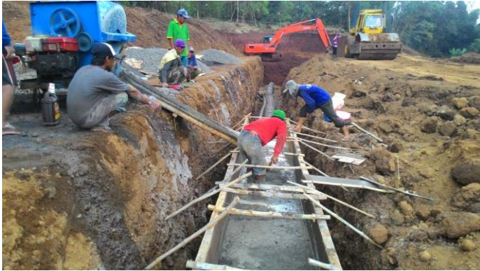
Gambar 4. 66 Pengecoran pada pipa outlet Sumber : Dokumentasi PT. Pandu Putra Primatama
