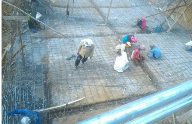
Gambar 4. 87 Penulangan pada plat pelimpah Sumber : Dokumentasi PT. Pandu Putra Primatama
