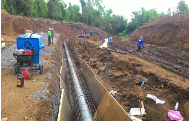
Gambar 4. 64 Penulangan pada pipa outlet Sumber : Dokumentasi PT. Pandu Putra Primatama
