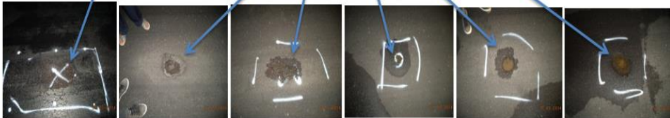
Kerusakan Permukaan Runway (tanggal 13 Maret 2014) Terjadi kerusakan berupa aspal mengelupas dan lubang Sumber: P.T. Angkasa Pura I
