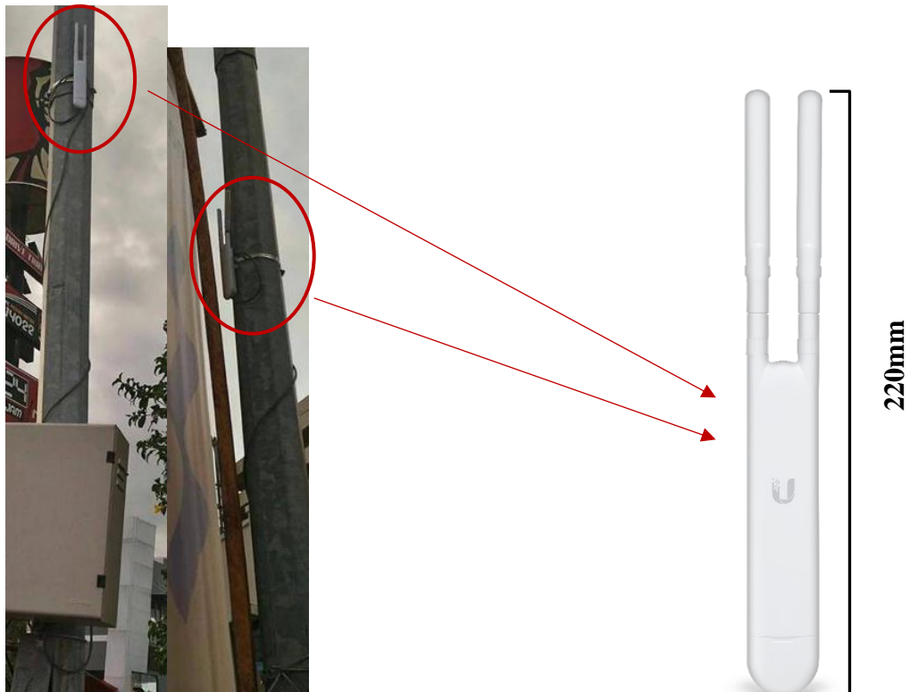
Gambar 4. 38 penempatan perangkat access network
