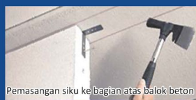
Pemasangan siku ke bagian atas balok beton
