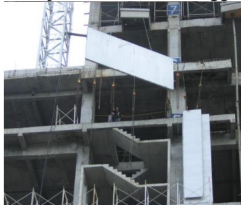
Gambar 4.15 Proses Erection Beton Pracetak Menuju Titik Pemasangan
