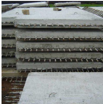
Gambar 4.10 Penumpukan Dinding Pracetak Horizontal
