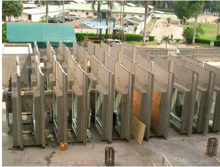
Gambar 4.9 Penumpukan Dinding beton pracetak Secara Vertikal
