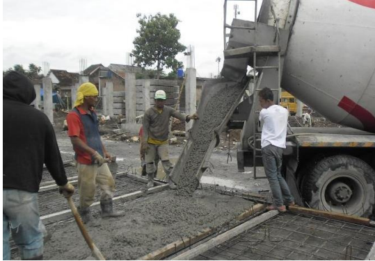
Gambar 4.6 Proses Pengecoran Dinding Beton Pracetak
