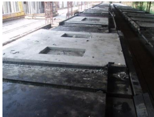
Gambar 4.3 Cetakan Beton Pracetak Setempat
