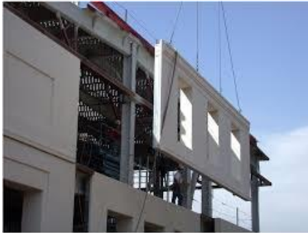
Gambar 4.13 Erection Dinding Pracetak ke Titik Lokasi
