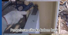
Pengelasan siku ke kolom baja
