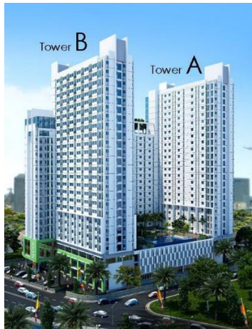
Gambar 3.2 Tower A dan Tower B pada Apartemen Gunawangsa MERR Surabaya
