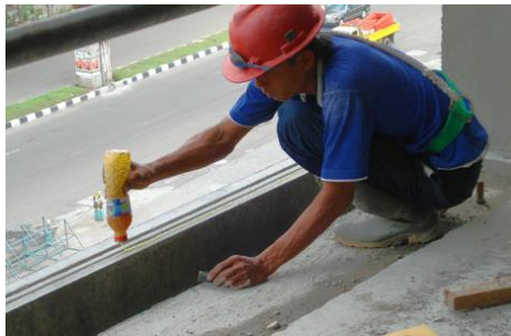
Gambar 4.21 Proses Pemberian Perekat pada Sisi Panel
