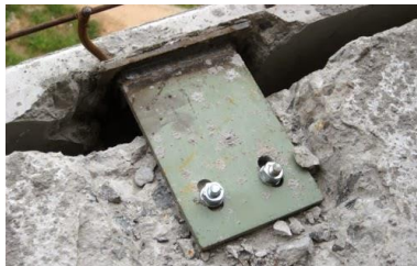
Gambar 4.2 Embedded Plat Baja
