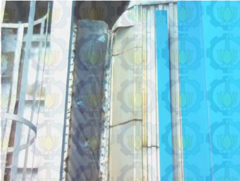
Gambar 4.1 Gambar actual Expansion nomer 5 HRSG unit 3.1
