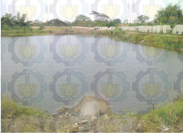
Gambar 4.4. Saluran Baru membuang air ke Bosed melewati gorong-gorong berupa pipa.
