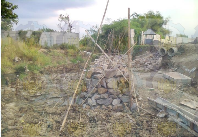
Gambar 4.7. Outlet Bosem membuang air menuju saluran Lontar.
