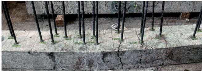
写真-3 施工状況
