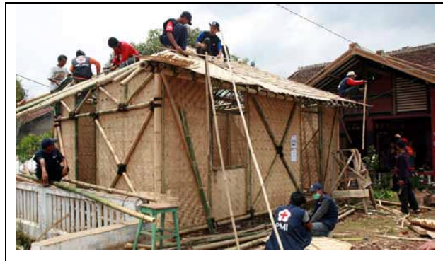
Gambar 1. 4. Rumah Bambu Dibangun di Kampung Haurgombong, Desa Jagabaya, Kec. Cimaung, Kab. Bandung. 6
