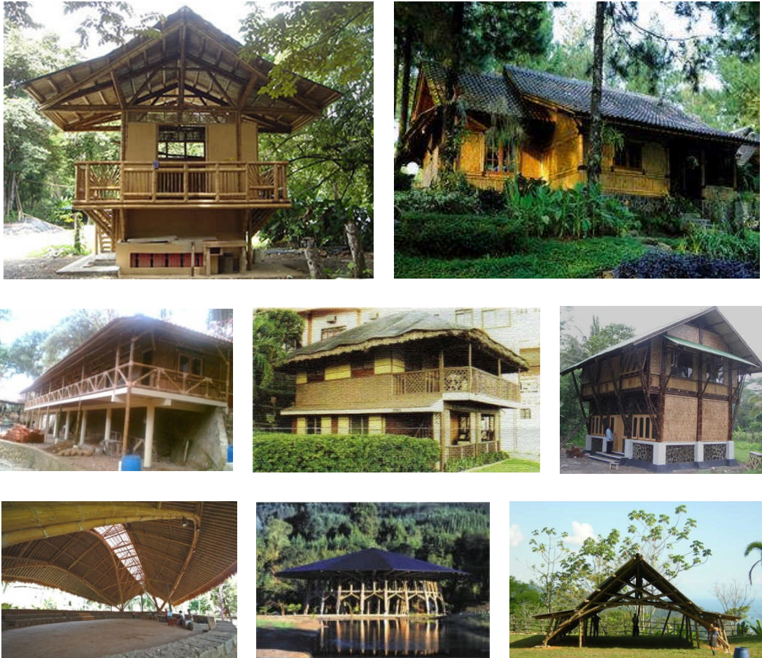
Gambar 2. 23. Beberapa Contoh Bangunan Bambu Sumber: green home buildings
