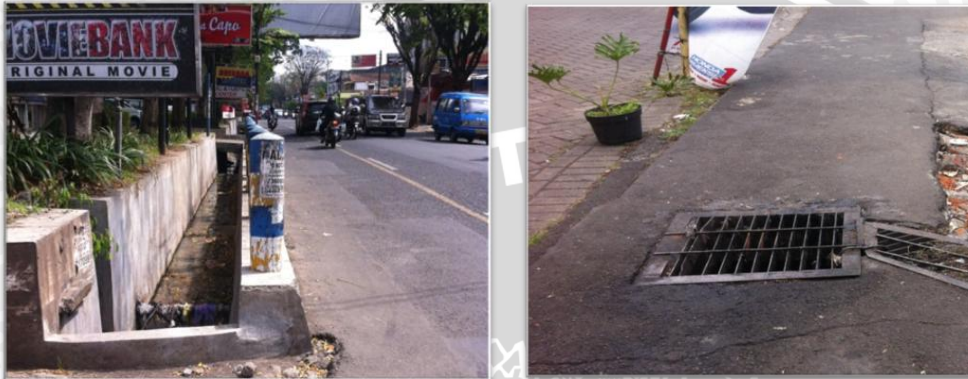
Gambar 4.17 Saluran Drainase Terbuka dan Tertutup di Koridor Jalan MT. Haryono
