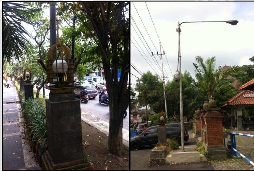
Gambar 4.18 Kondisi Lampu Penerangan di Koridor Jalan MT. Haryono
