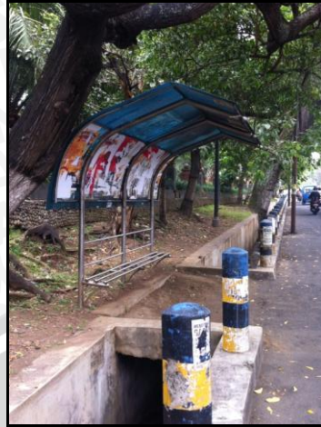
Gambar 4.23 Kondisi Halte/Shelter di Koridor Jalan MT. Haryono Sumber: Hasil Survei, 2015
