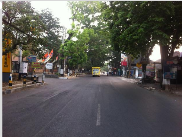
Gambar 4.11 Penampang Koridor Jalan MT. Haryono Segmen 4 Sumber: Hasil Survei, 2015
