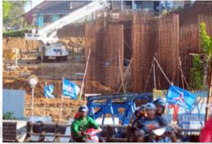
Gambar 11 Keadaan Pembangunan Jembatan Kedungkandang
