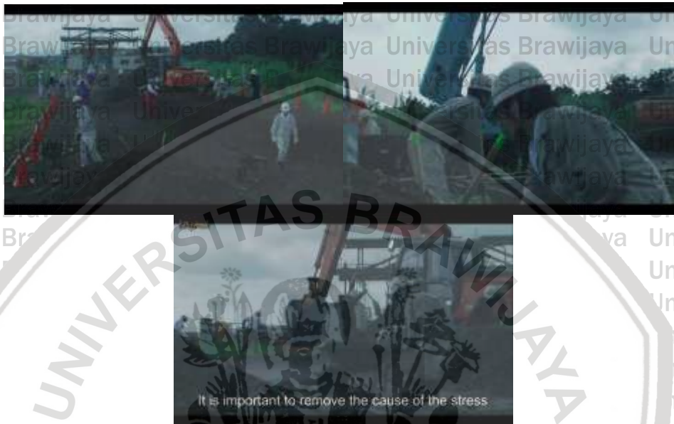
Gambar 3.29 Seiji dan para pekerja tetap melanjutkan pekerjaan meskipun hujan
