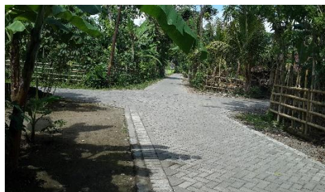
Gambar 2.6 kondisi jalan menuju pemukiman warga
