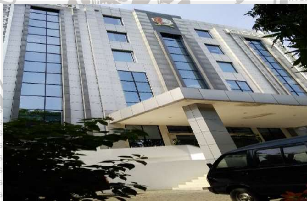
Gambar 13. Gedung Baru Pemkab Bojonegoro
