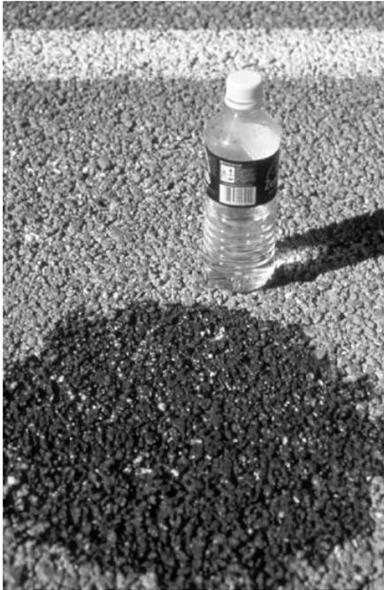
*Gambar 2.2* Infiltrasi pada permukaan beton *porous* di tempat parkir akuarium florida di Tampa, Florida
