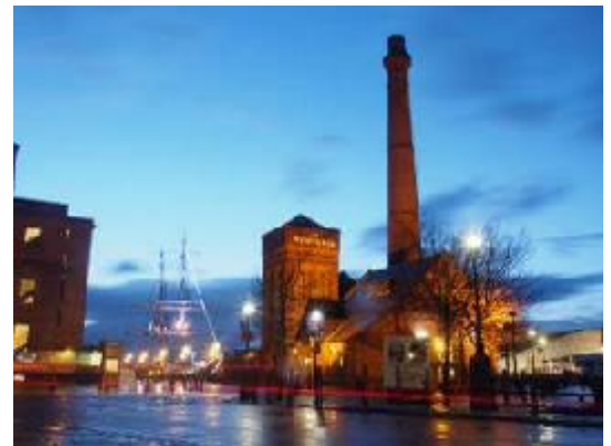
Gambar 7: The pump house yang telah beralihfungsi menjadi bar yang cantik dan ramai pengunjung
