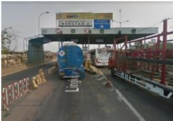
Gambar 1. Kondisi Eksisting Gardu Tol Rorotan 2
